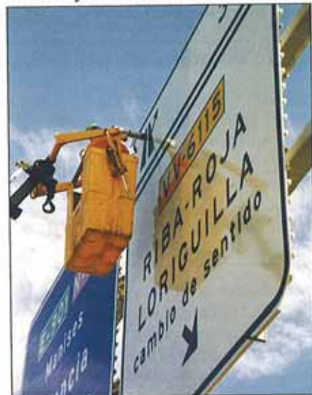
Figura 5. Determinación de las características de la señal instalada
