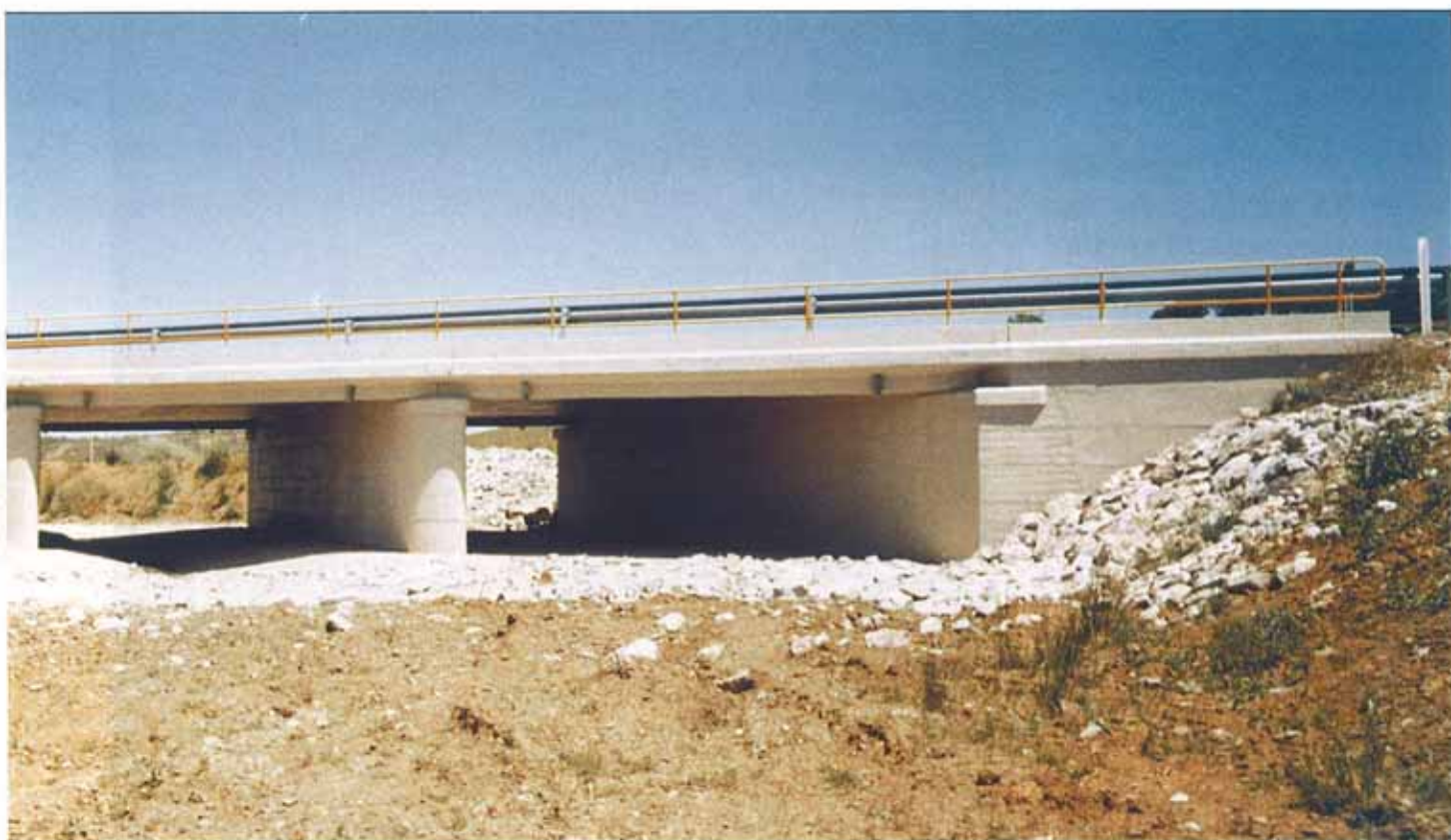
La foto muestra las obras de reparación de un puente realizadas de acuerdo a un Programa especial del Ministerio de Fomento
