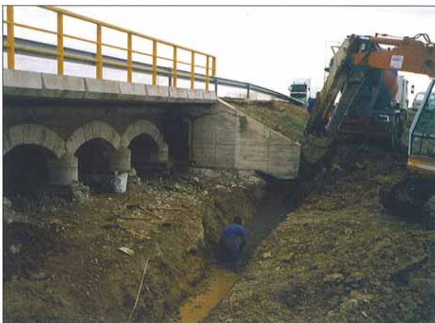
Las adecuadas inspecciones nos informan sobre el estado del puente y su necesaria rehabilitación
