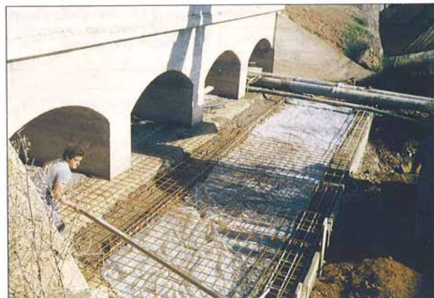
Foto panorámica y de detalle de las obras de reparación del puente
