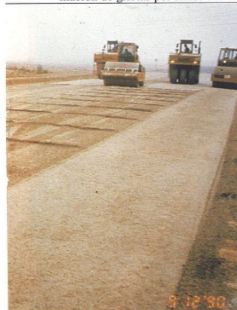
Compactación de la capa tras la prefisuración
