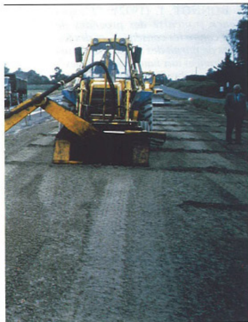
do juntas transversales en fresco cada 3 m
