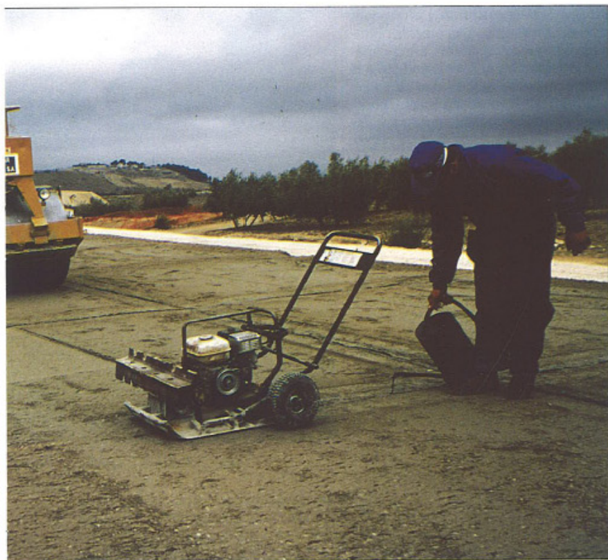
fresco en el hormigón compactado. Variante de Torredonjimeno (Jaén). Diciembre de 1995
