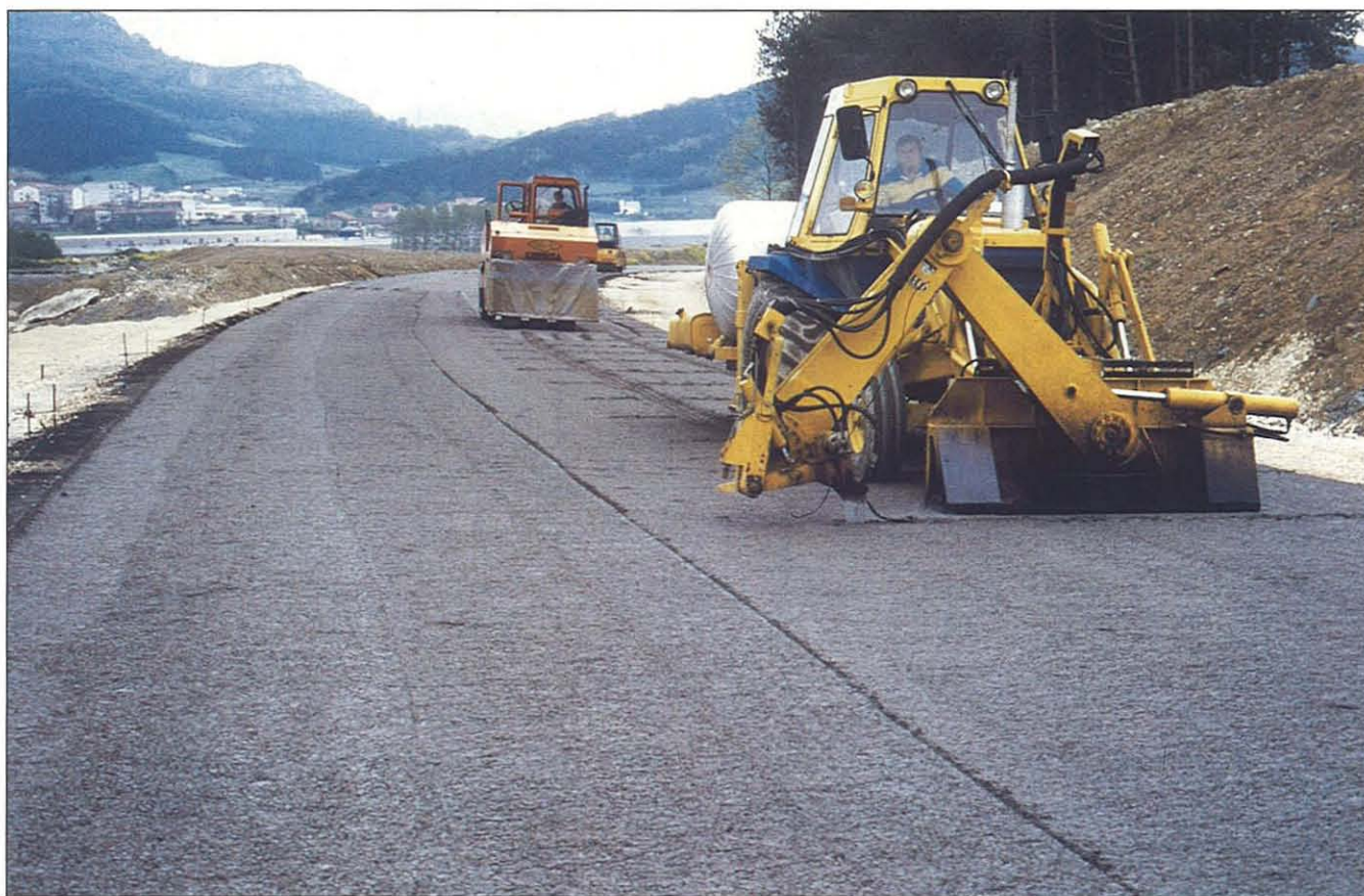
Ejecución de juntas en fresco con el equipo CRAFT en la variante de Irurzun (hormigón compactado)
