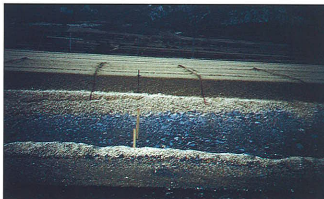
Figura 11. N - I, Salvatierra: juntas transversales creadas en fresco
