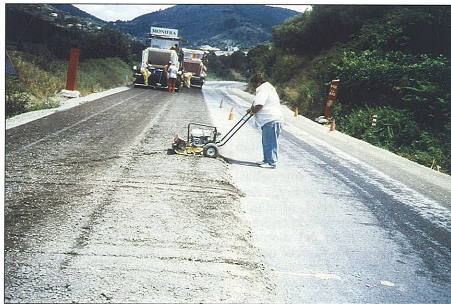
Figura 14. N - 630, Cáceres - Salamanca: prefisuración de firme reciclado con cemento
