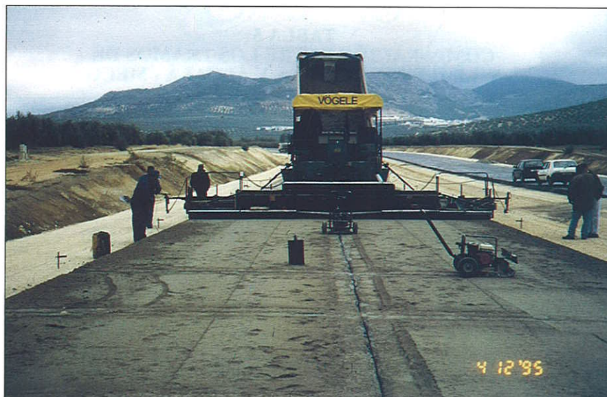
Figura 7. Variante de Torredonjimeno (hormigón compactado): creación de junta longitudinal y de juntas transversales en fresco con placas vibrantes
