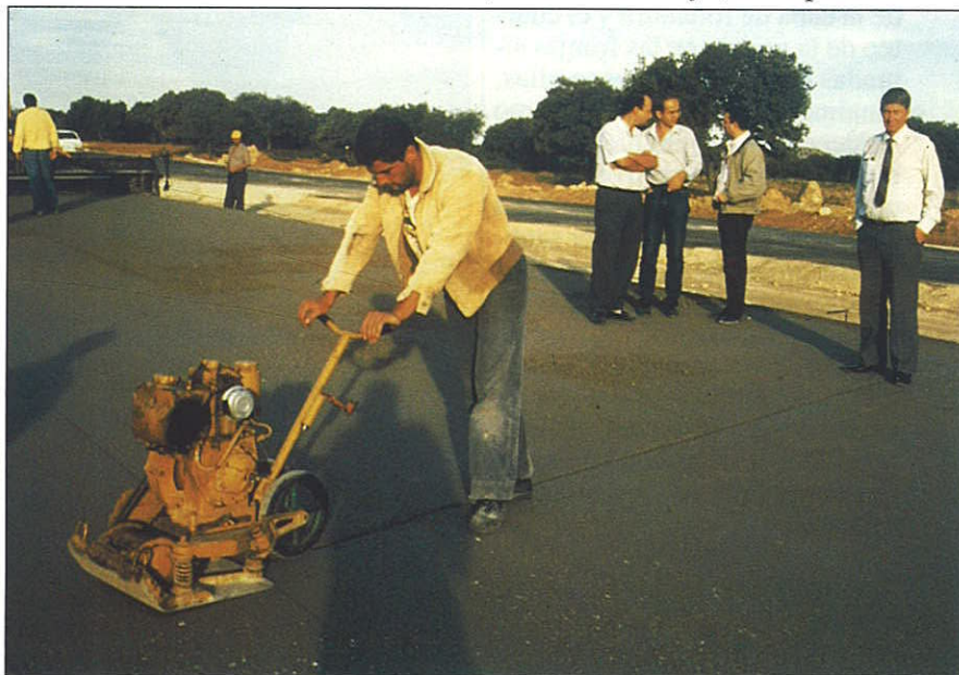
Figura 4b. Variante de Archidona: realización de junta en fresco en el hormigón compactado
