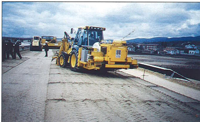
Figura 10. N - I, Salvatierra: equipo CRAFT desplazándose para formar una nueva junta
