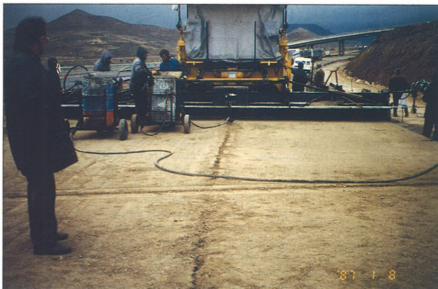
Figura 8a. Variante de Medinaceli (hormigón magro compactado): creación de juntas transversales con placa vibrante, provista de dispositivo de inyección de emulsión, y de junta longitudinal mediante cuchilla incorporada a la extendidora
