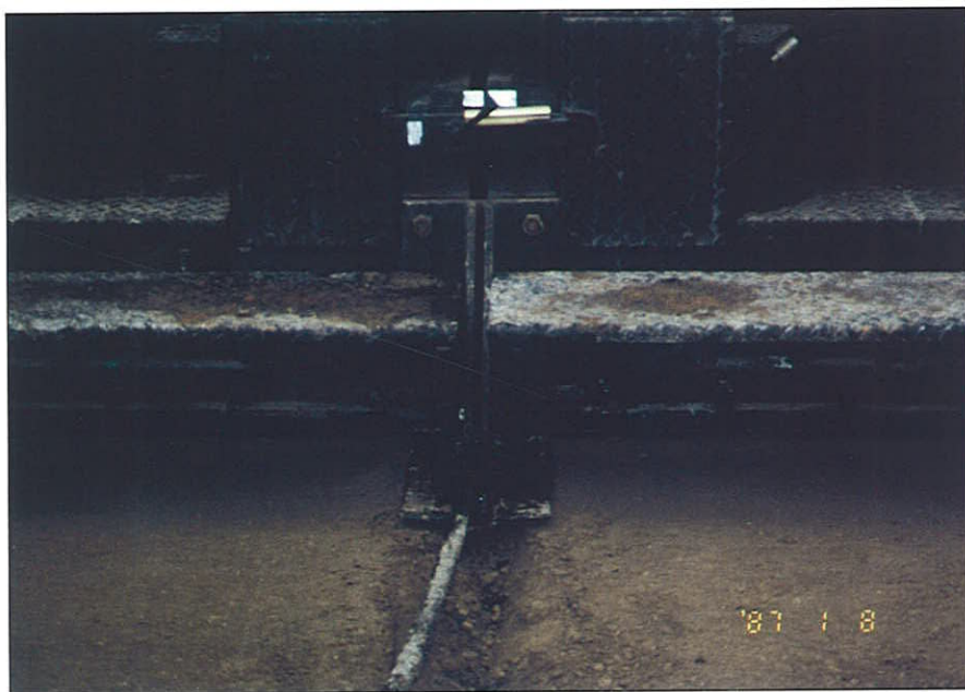
Figura 8b. Variante de Medinaceli: detalle de formación de la junta longitudinal
