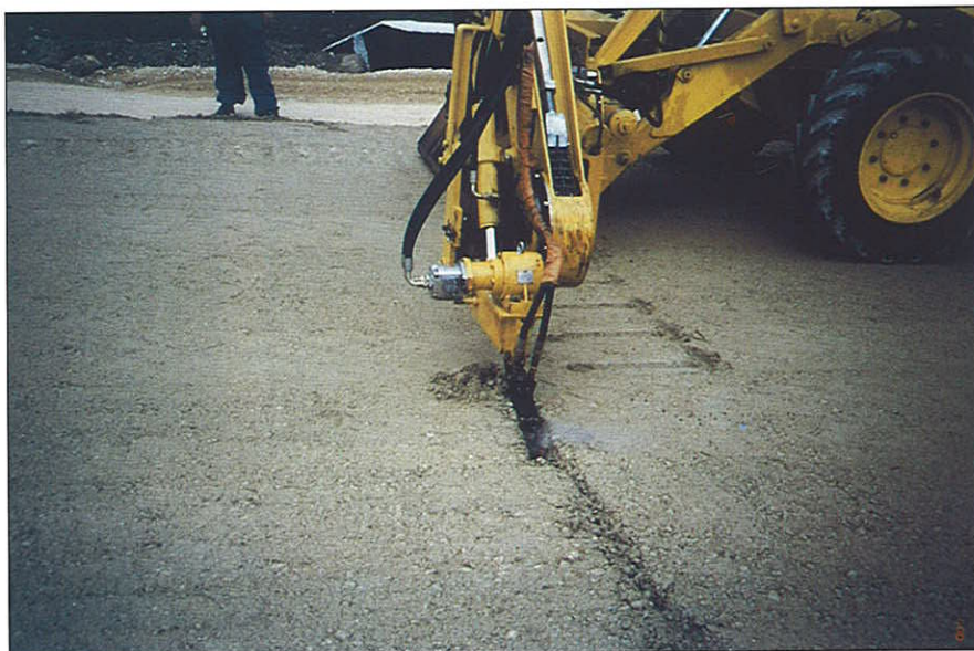
Figura 9. N - I, Salvatierra (gravacemento): detalle de creación de junta en fresco con equipo CRAFT
