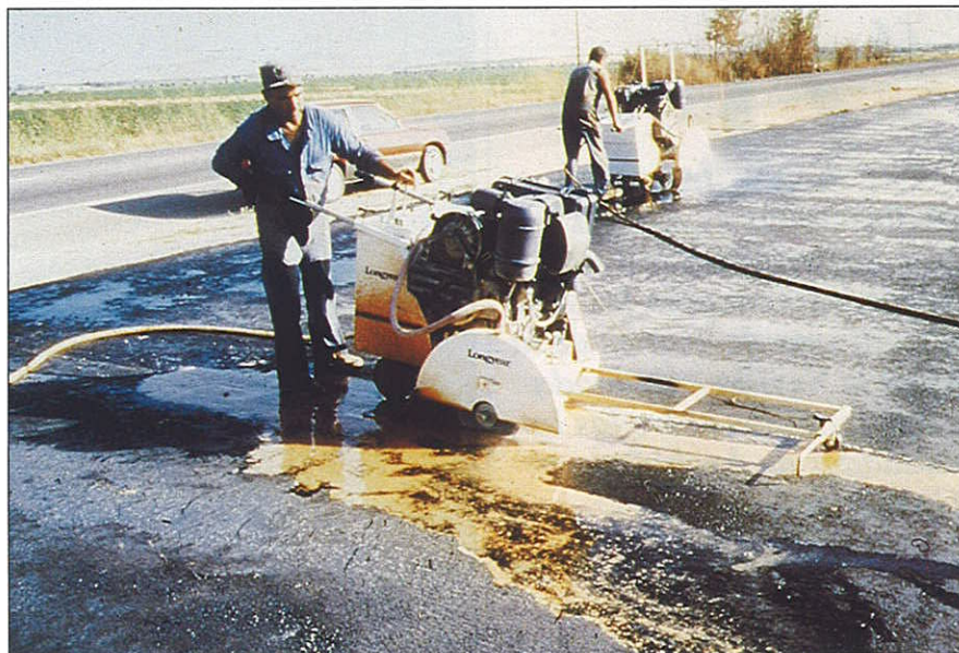
Figura 1. Valdepeñas - Almuradiel (hormigón compactado): ejecución de juntas por serrado
