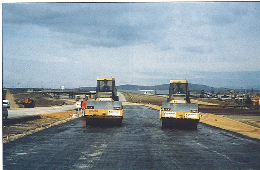
Figura 12. N - I, Salvatierra: paso de rodillos sobre la gravacemento endurecida para forzar la apertura de las juntas creadas en fresco
