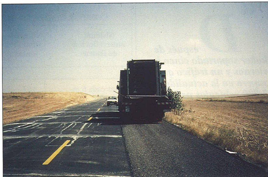
Figura 5. Sanchidrián - San Pedro del Arroyo: extensión de membrana de betún modificado sobre el hormigón compactado
