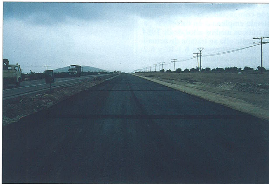
Figura 2. Valdepeñas - Almuradiel: bandas de geomalla sobre las juntas
