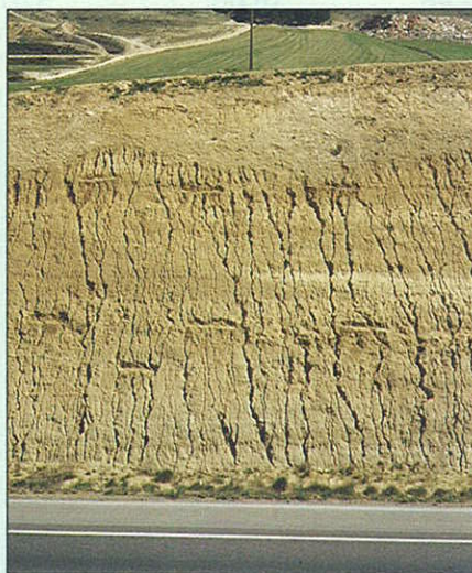
Foto 7. Se aprecia el inadecuado espaciamiento de las banquetas de plantación. Estas no interceptan los regueros y la falta de alcorques provoca su desbordamiento y la generación de nuevos regueros
