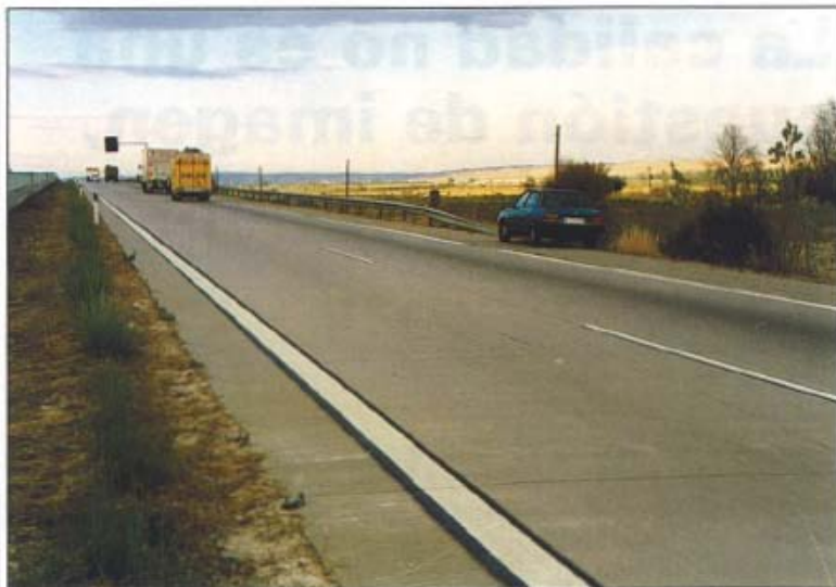
Autovía con pavimento de hormigón señalizada con pintura blanca sobre imprimación negra.
