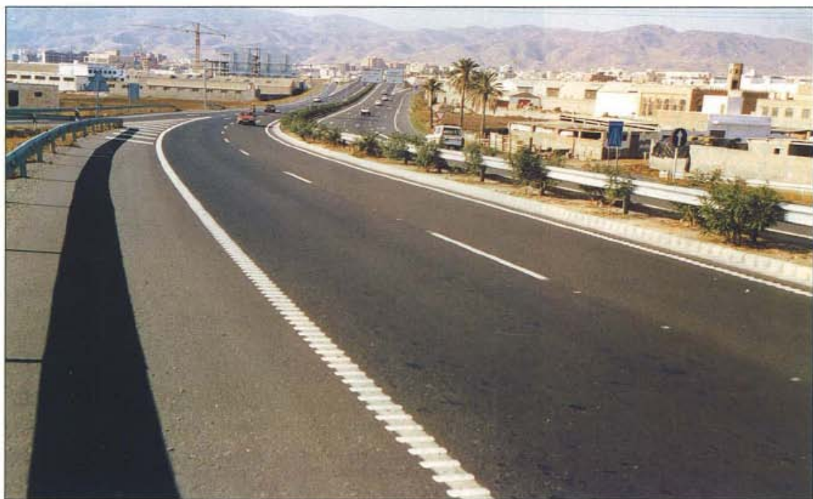
Figura 11. Autovía con señalización en forma de perfiles en las marcas de borde.
