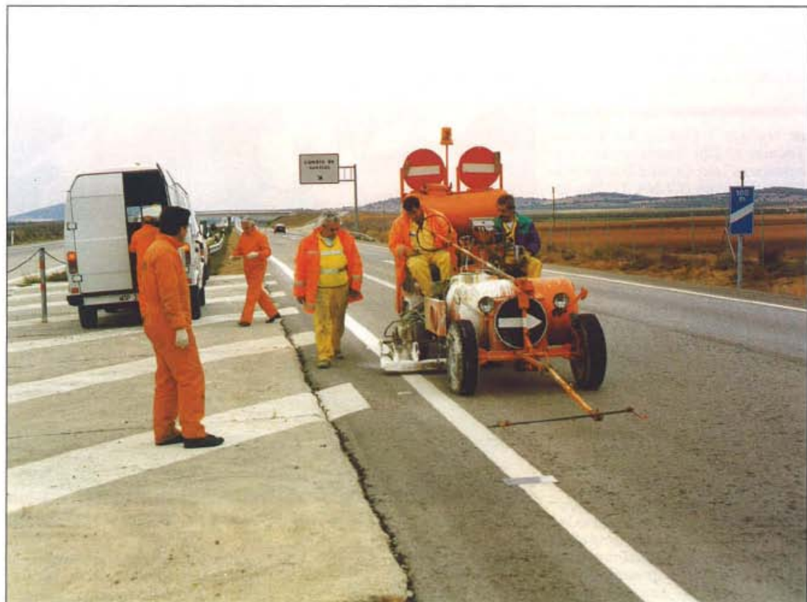
Figura 1. Determinación de la dosificación de los materiales mediante placas metálicas.
