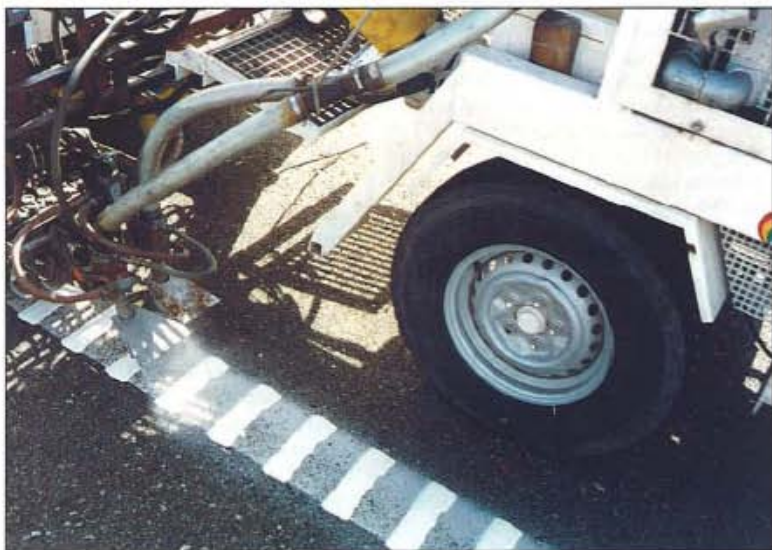
Figura 9. Aplicación de señalización horizontal en forma de perfiles.
