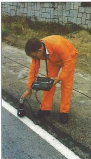
Figura 5. Medida de la visibilidad diurna de las marcas viales.
