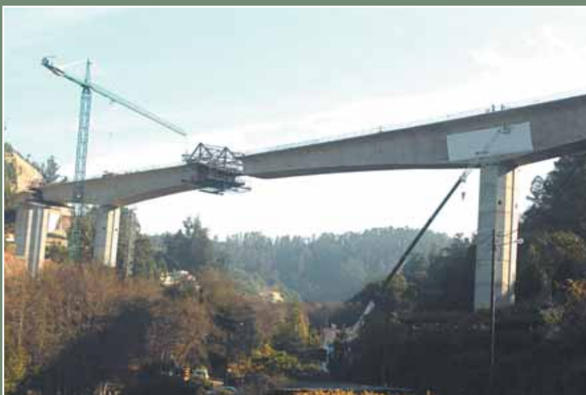
Ejecución del viaducto sobre el río Umia mediante voladizos sucesivos ejecutados in situ .
