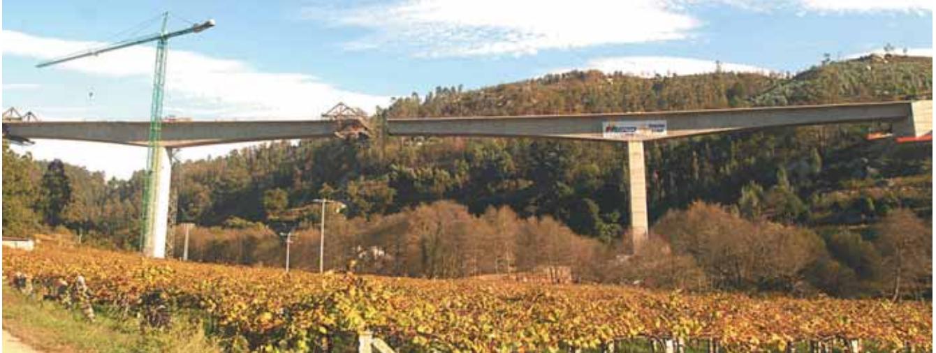
Viaducto sobre el río Umia en proceso de ejecución.
