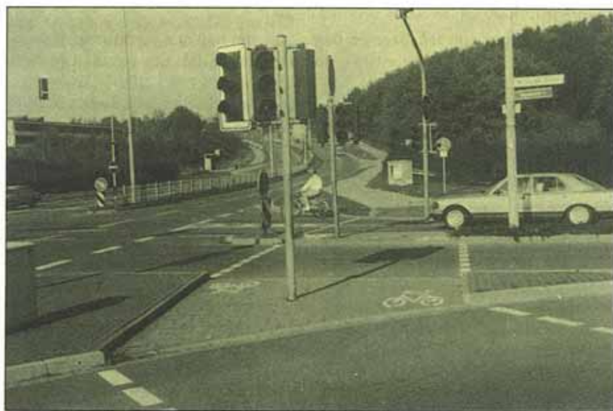
Fig. 14. Ejemplo de cruce para ciclistas por una intersección correctamente señalizado.
