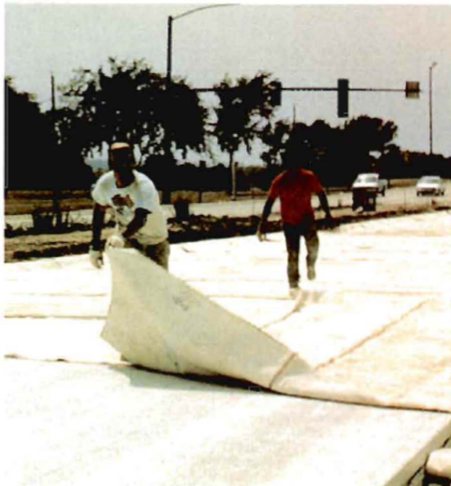
Colocación de lonas aislantes, tan pronto se pueda pisar el hormigón (British Cement Association).
