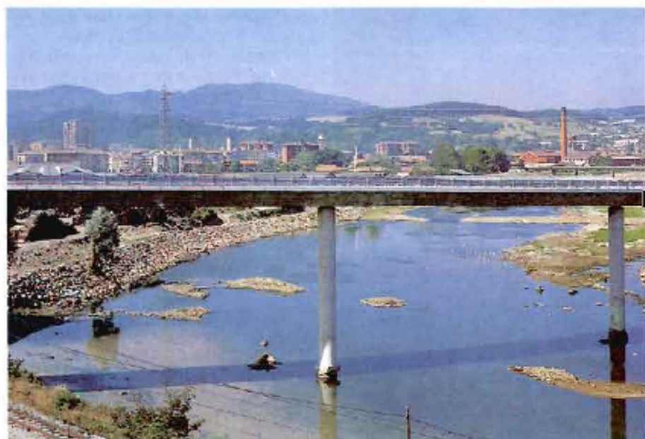
Aquí el viaducto facilita la circulación y salva el impacto medioambiental.
