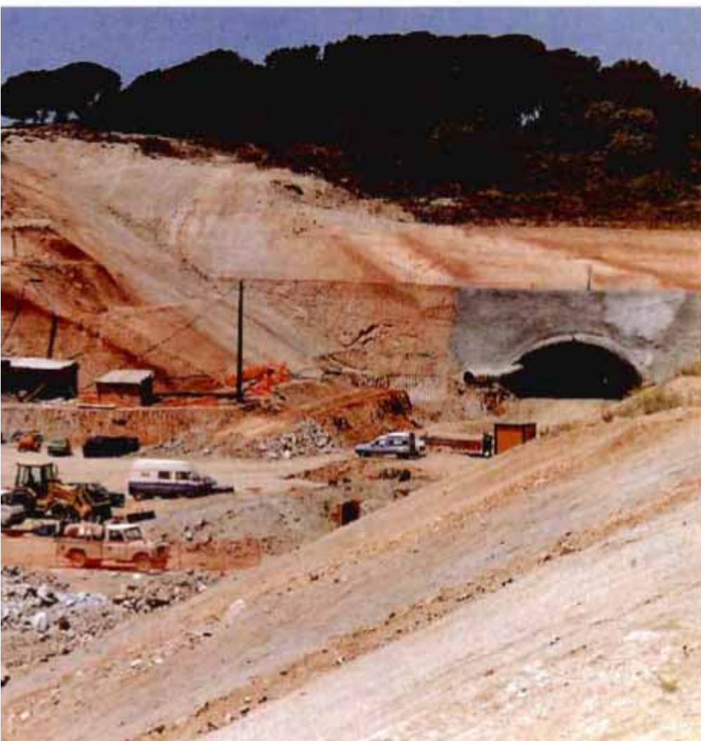
Para salvar el monte se realizan los túneles cuya zona exterior será repoblada.
