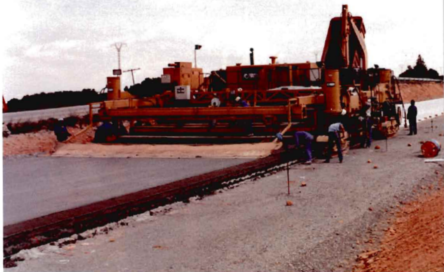
Foto 1. Firme de Hormigón. Extensión
