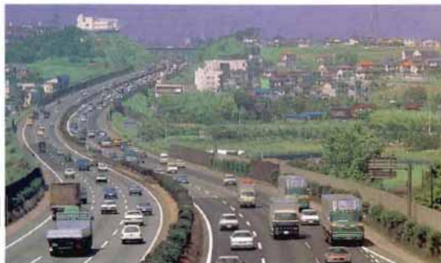
Con el distanciamiento de la traza se consiguen disminuciones de 3 dB(A).
