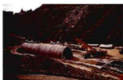
Obra de paso nº 12.
