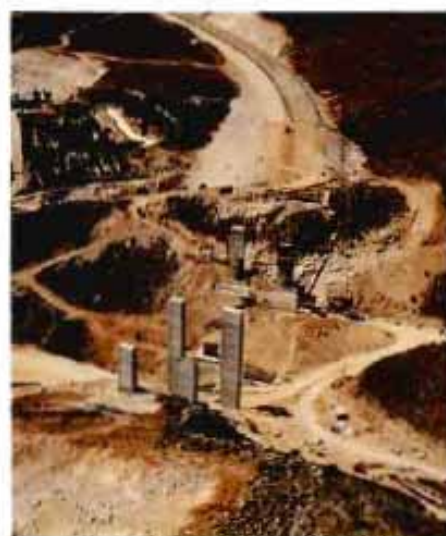
Viaducto en construcción.
