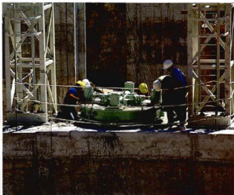
Detalle de colocación del anillo de giro.
