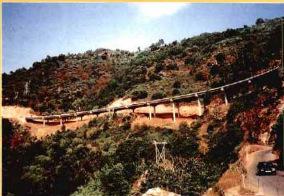
El viaducto de Os Picoutos tiene una longitud de 370 m y está constituido por 12 vanos iguales de 30,83 m.
