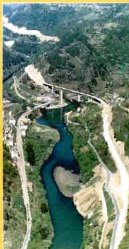
Al fondo se puede apreciar el puente de Os Peares que salva el río Sil en su confluencia con el Miño, de 353 m de longitud.
