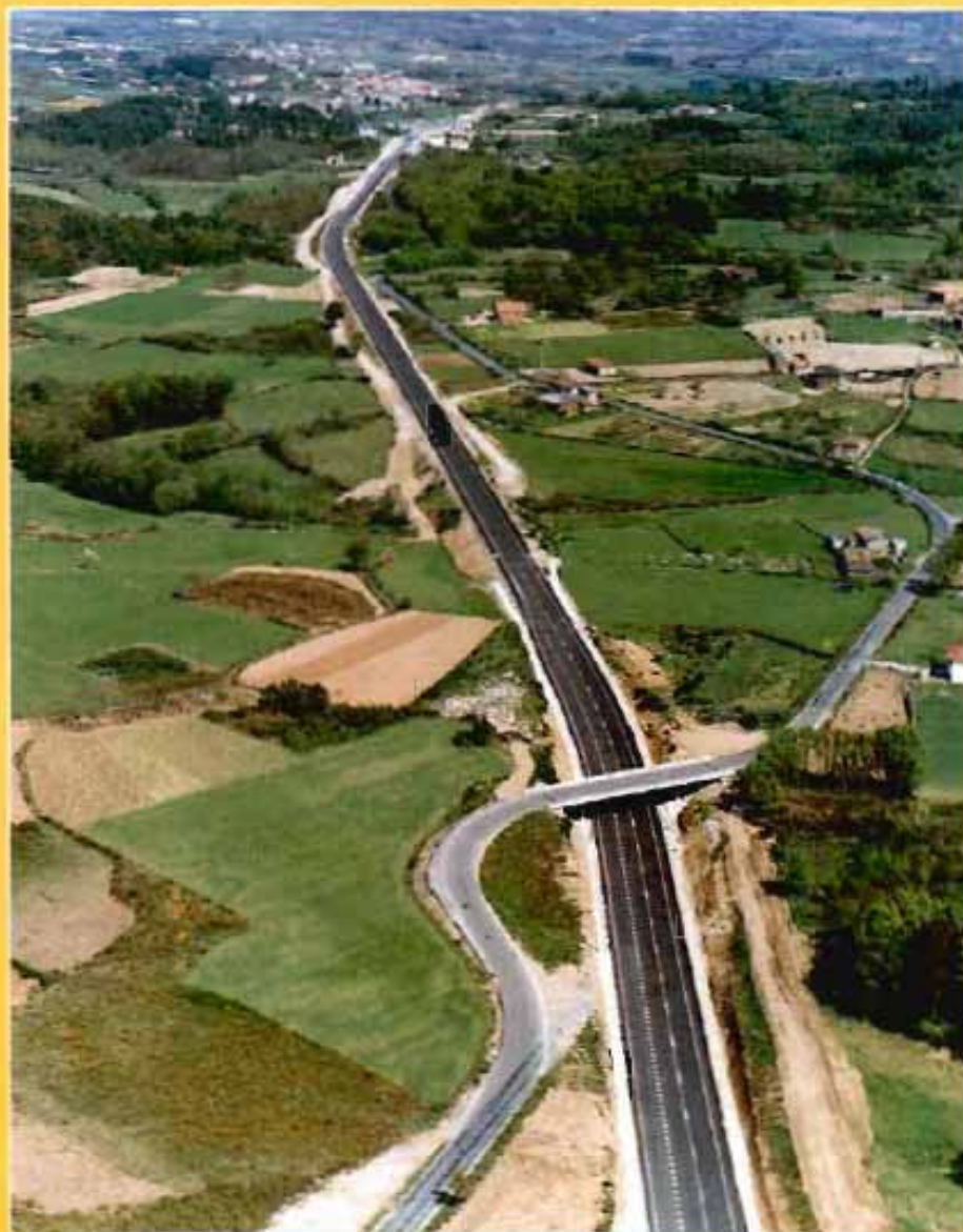
La foto recoge la obra terminada entre el pk 29+200 al pk 30+900 de esta vía rápida, de Penalva a Ferreira.
