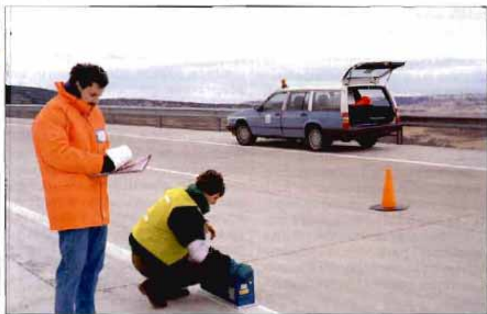
Control de marcas viales.
