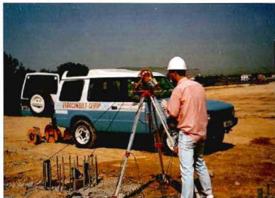
Control de integridad de cimentaciones profundas.
