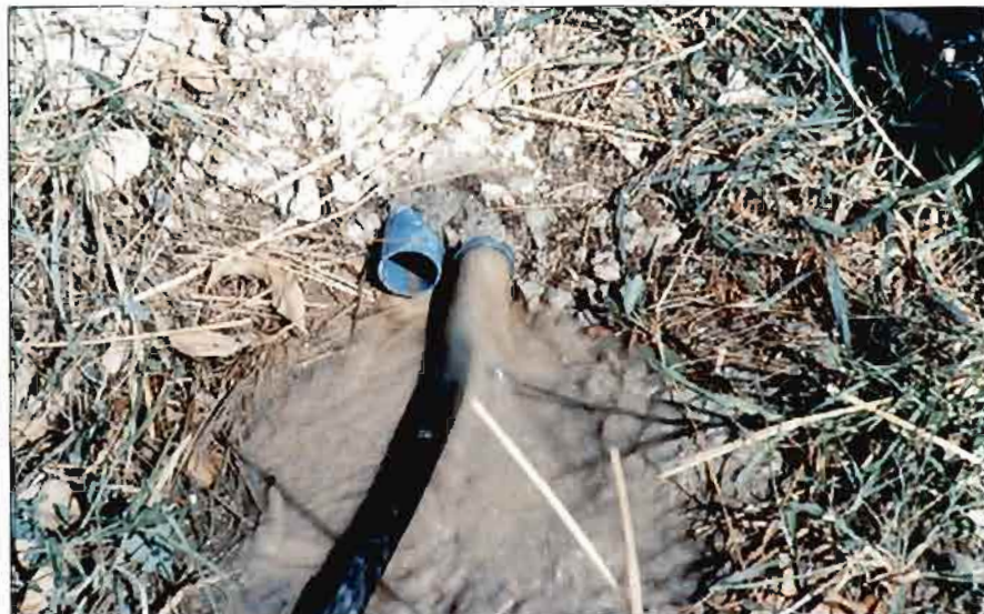
Foto 8. Detalle de la operación de limpieza de los tubos ranurados.
