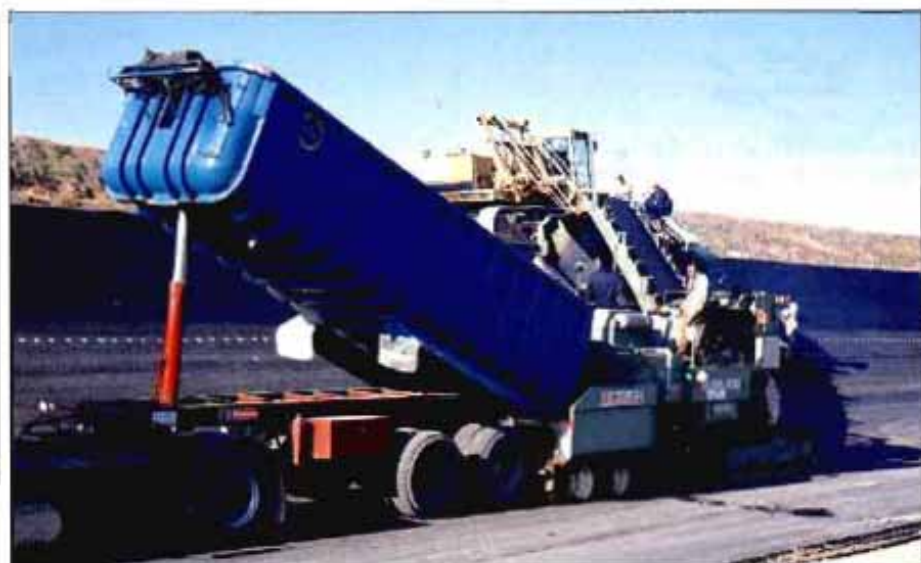
Construcción del anillo de velocidad del Instituto del Automóvil IDIADA. Las características del betón juega un papel importante en la construcción de estos pavimentos especiales.
