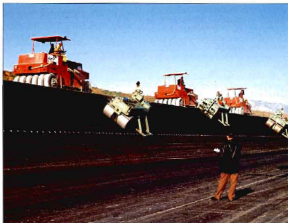
Compacción de la capa de rodadura del anillo de velocidad del Instituto del Automóvil, IDIADA.
