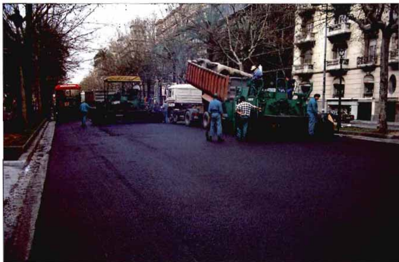
Extendido de un microaglomerado en una vía urbana. El método UCL es aplicado en la caracterización y control de los ligantes empleados.
