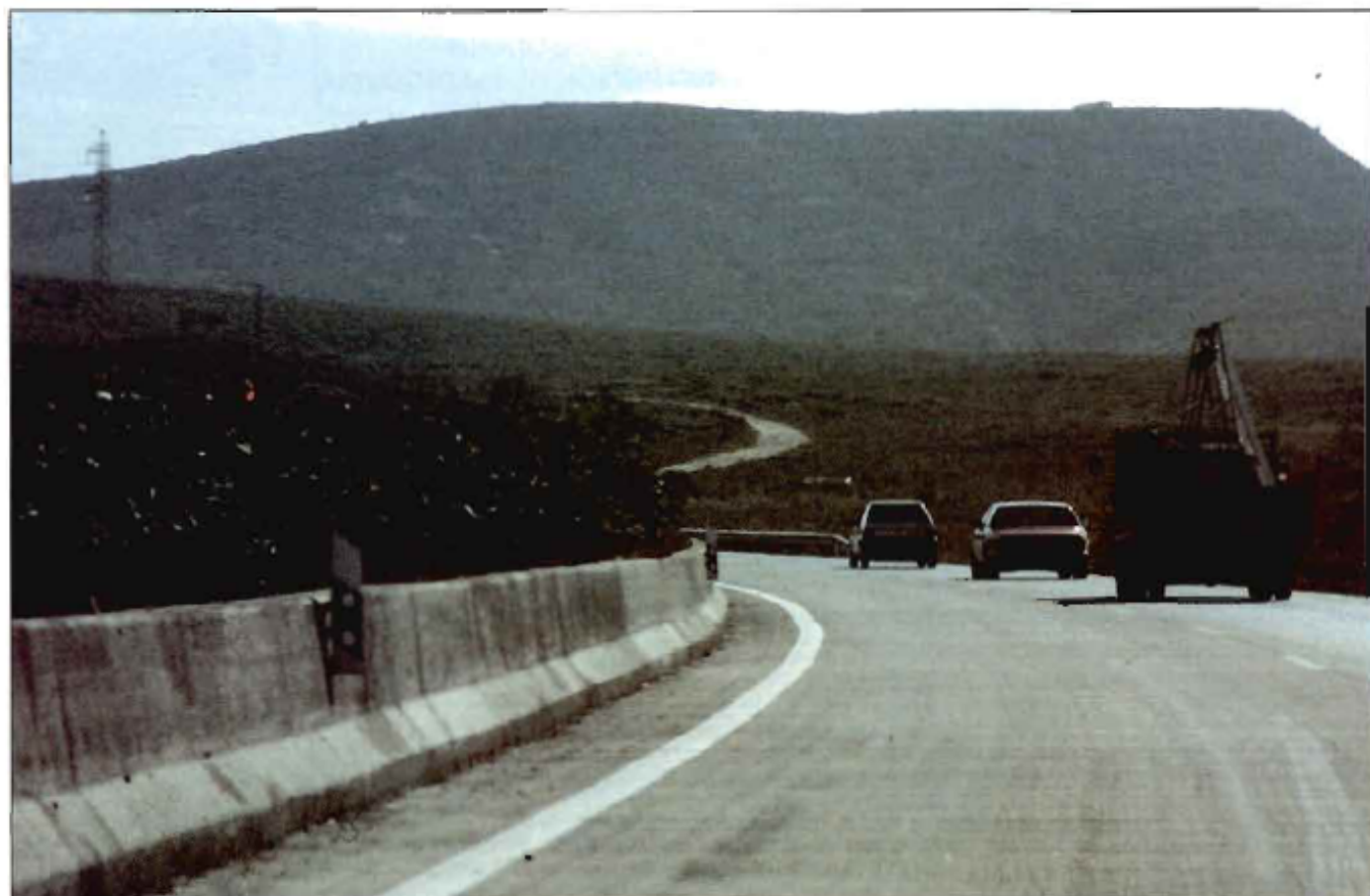
Se hace imprescindible regular, en la normativa de carreteras y de forma expresa, la afección de los posibles tratamientos en las medianas a la visibilidad necesaria para una detención de emergencia.
