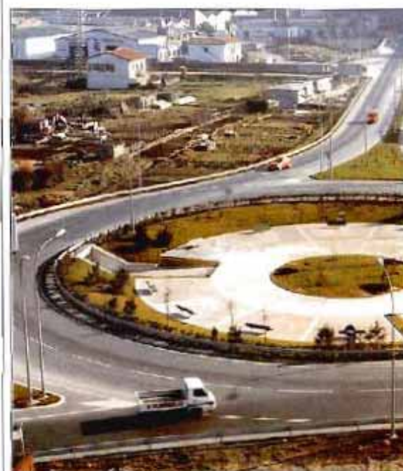
Ejemplo de desviación de carretera y construcción
