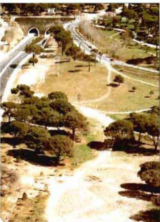
Coste oneroso para la Administración de carreteras. Eje Sinesio Delgado-Puerta de Hierro. (Madrid).
