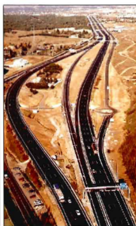
Calzada Bus/VAO en la N-VI, Madrid-La Coruña.
