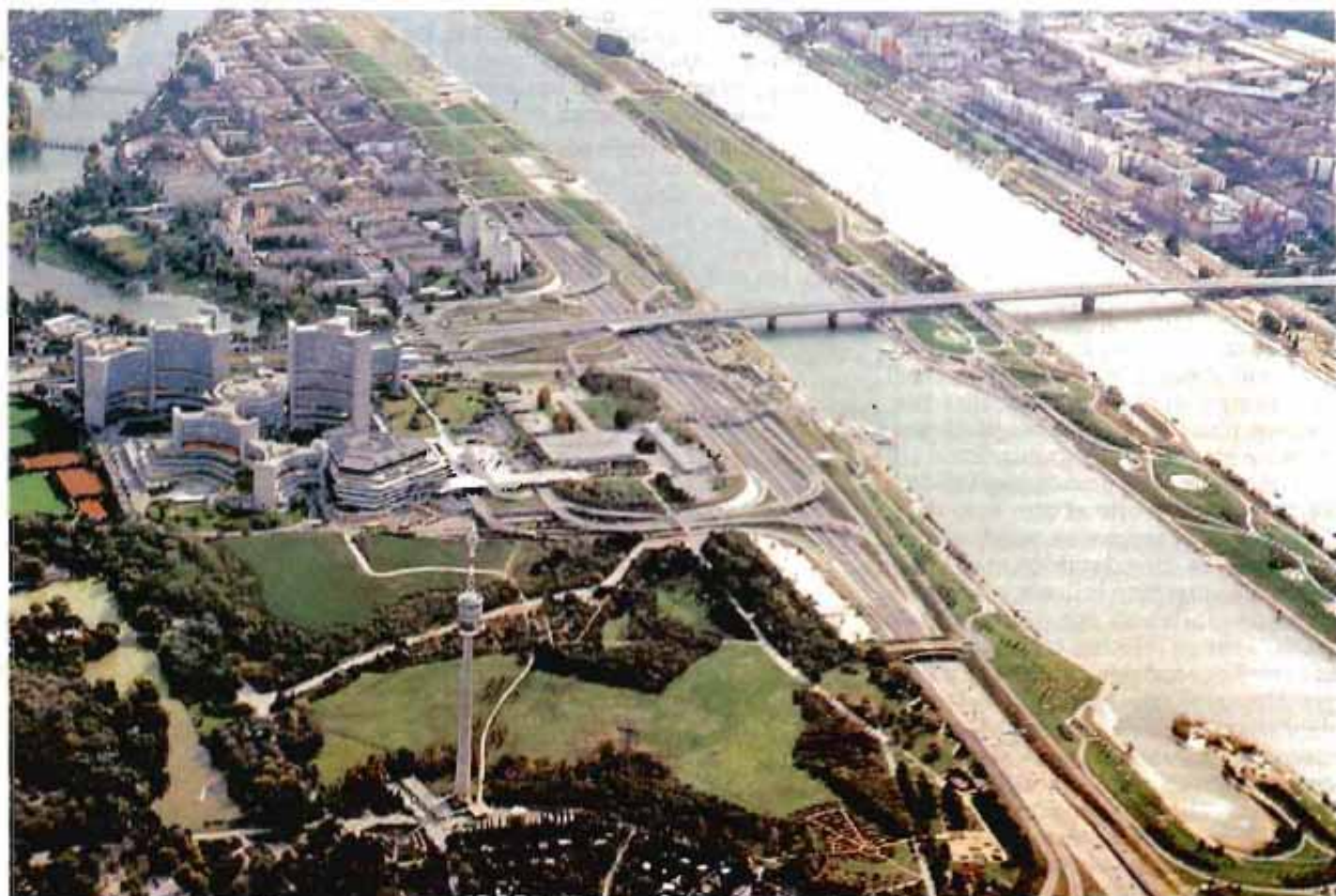
La política de conservación en Austria se centra en dos aspectos fundamentales: el número de accidentes y las secciones en donde es necesaria una reconstrucción total o parcial del cuerpo del firme. Foto: Autopista Donauufer, Viena (Austria)
