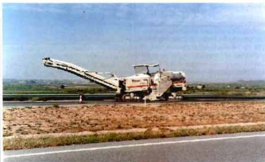
La función estructural depende de la propia capacidad resistente, así como del estado de envejecimiento de la rodadura.
