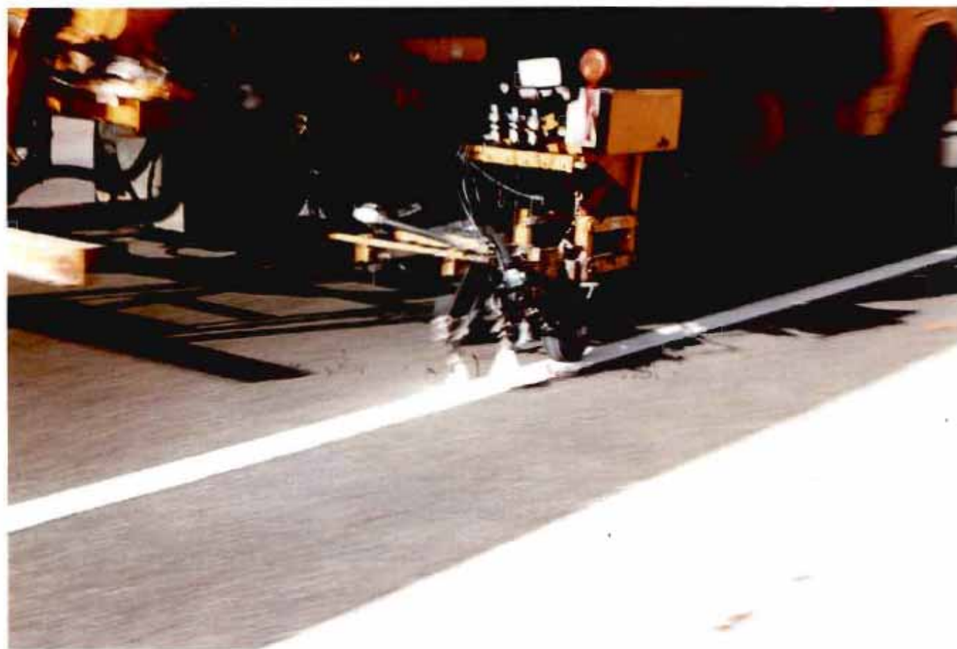
En general, la pintura que mejor se adapta a todas las condiciones ambientales, incluyendo las más desfavorables, es la acrílica termoplástica.
