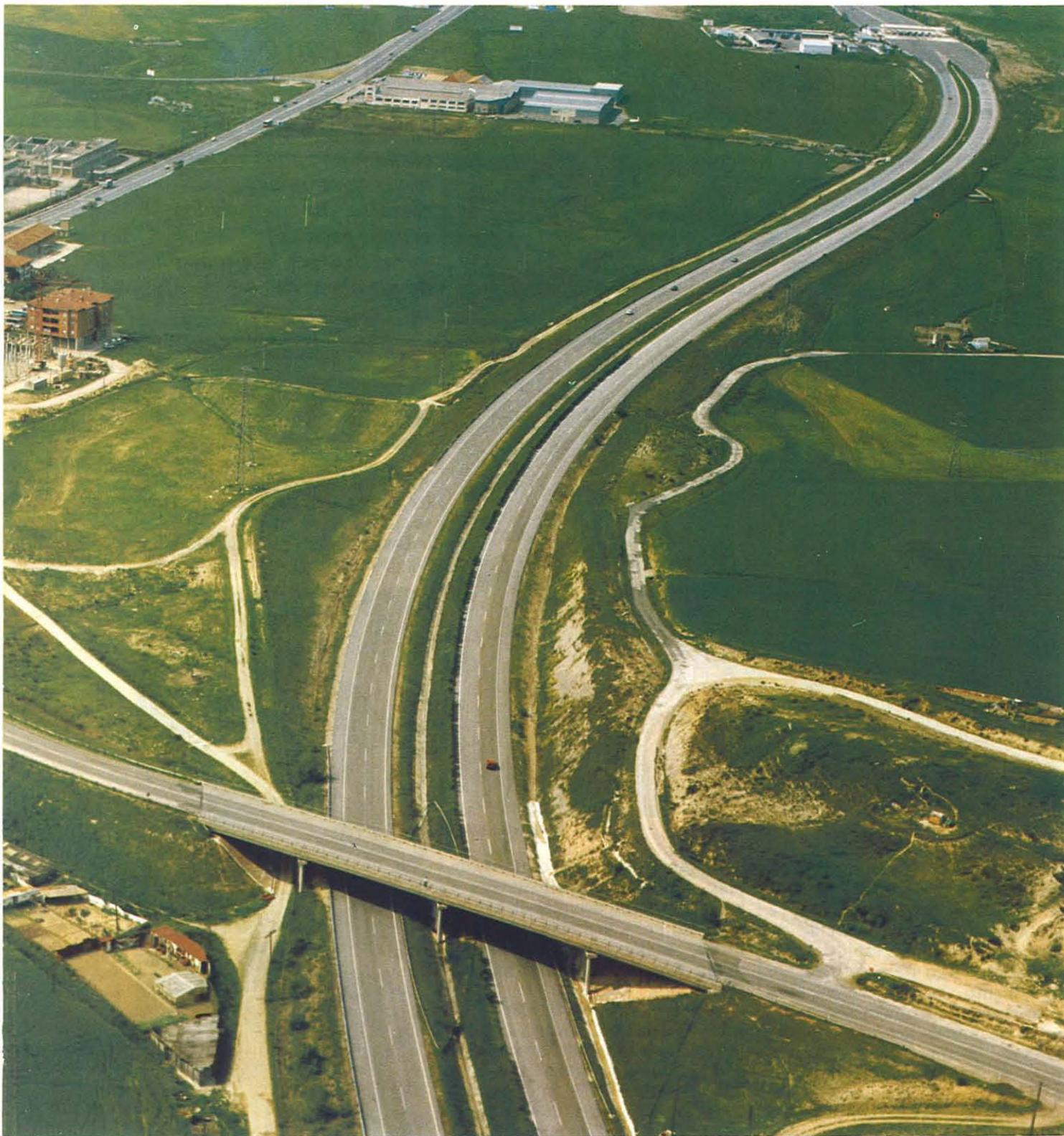
Vista parcial Autovía
