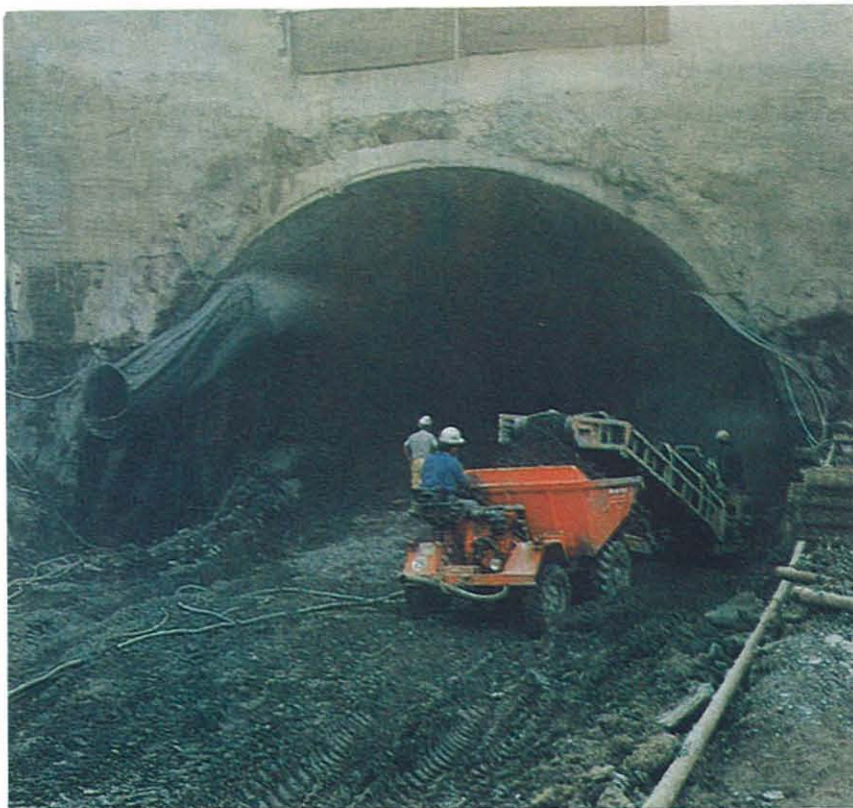
Túnel en construcción de la variante de Vera de Bidasoa
