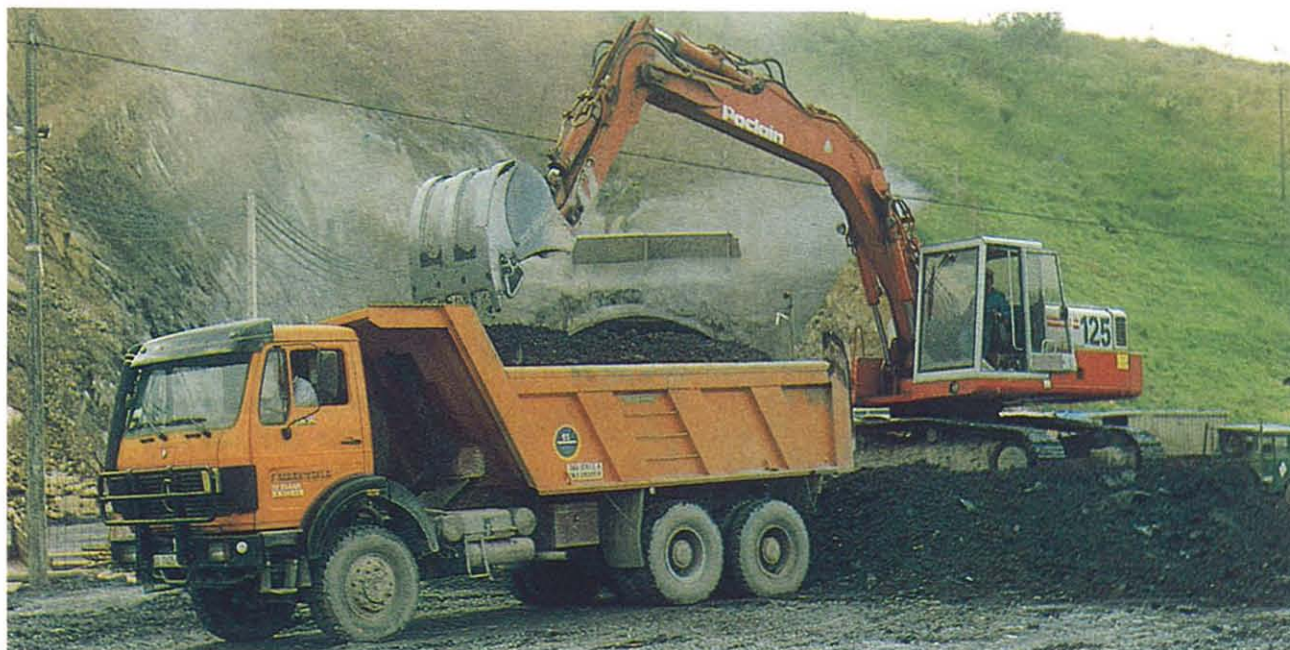
Obras en la N-121-A, Pamplona-Behobia
