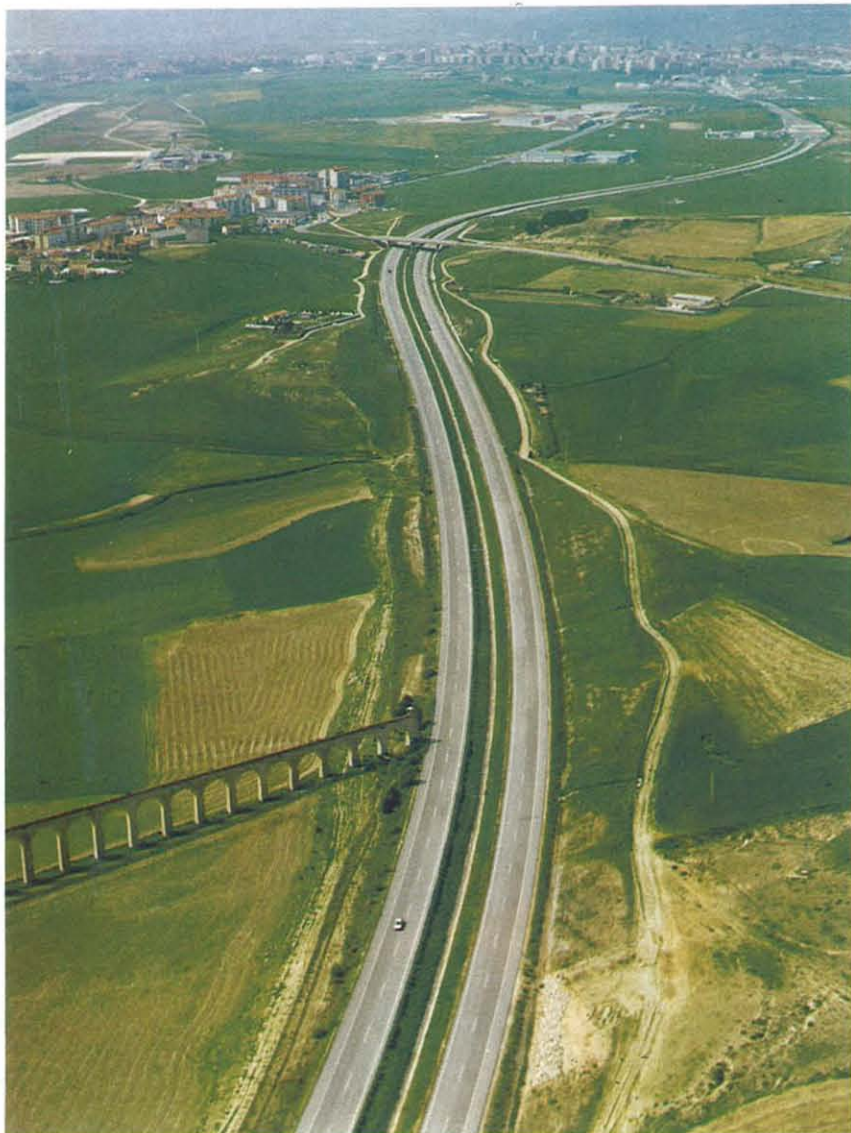
Vista parcial Autovía
