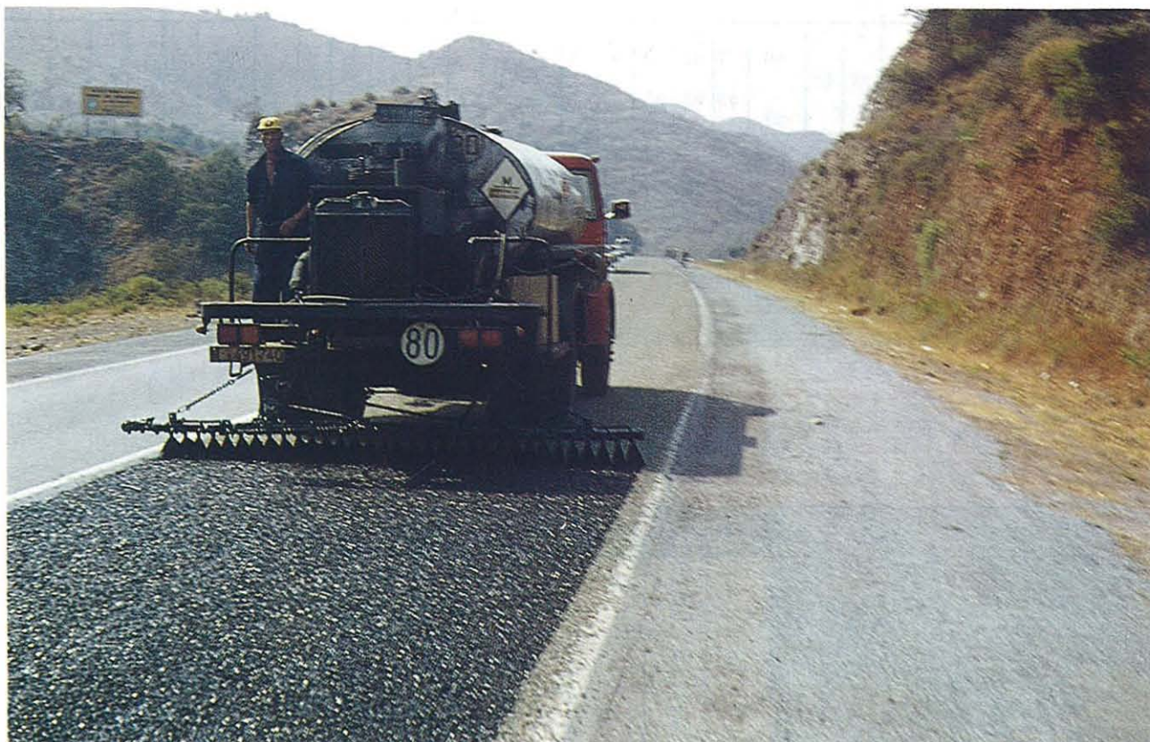
Uso de emulsión de Rotura Rápida en tratamiento superficial (España)
