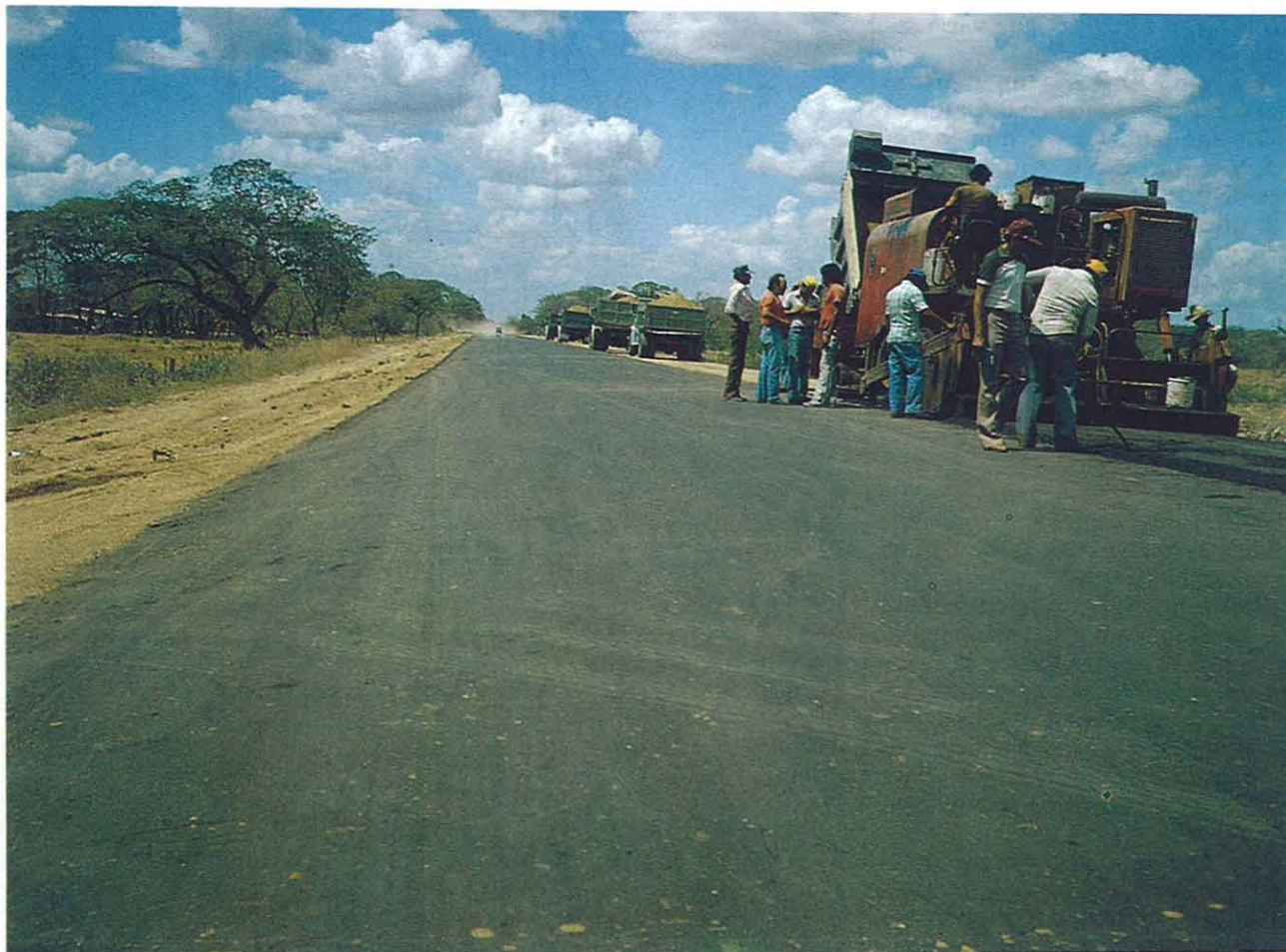
Empleo de emulsión de Rotura Lenta en estabilización de arenas (Venezuela)
