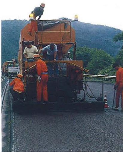
Empleo de emulsión de Rotura Controlada en microaglomerado en frío (Autopista Italiana)
