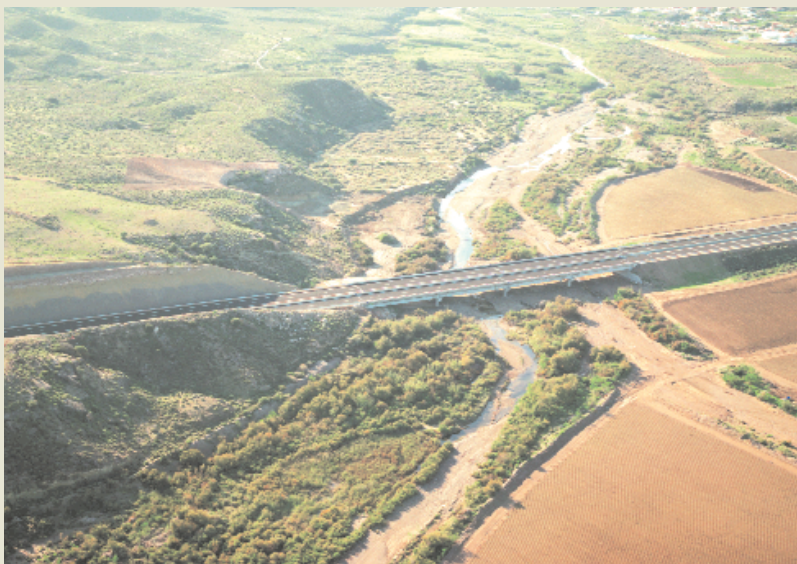
Un total de 181 estructuras se han construido a lo largo del tramo inaugurado.
