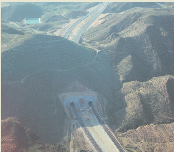
A lo largo del trazado se han construido los túneles de las sierras de Aguilón, Loma de Bas y de lo Alto y un falso túnel de 660 m cuyo recorrido suman un total de 7490 m de longitud.
