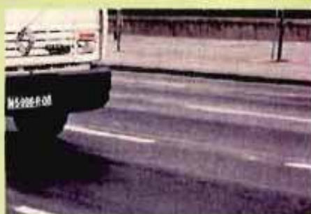
Roderos por fallo de la base.
