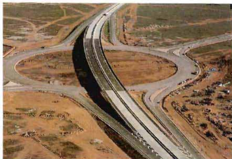
Circunvalación de Alicante. Doble barrera rígida de cemento con plantaciones.
