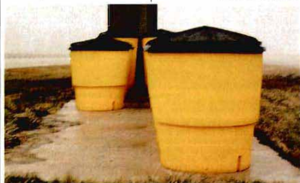
Unidades "containers" rellenos de arena para barreras de seguridad.
