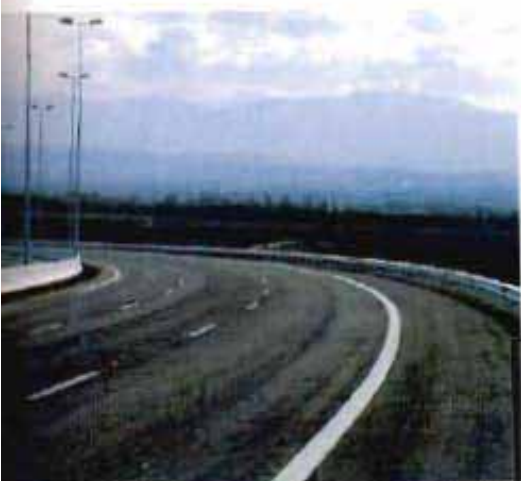
La protectora de poliestireno, rellena de hormigón "in situ".
