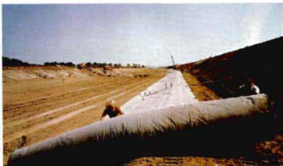
Extendido del geotextil
