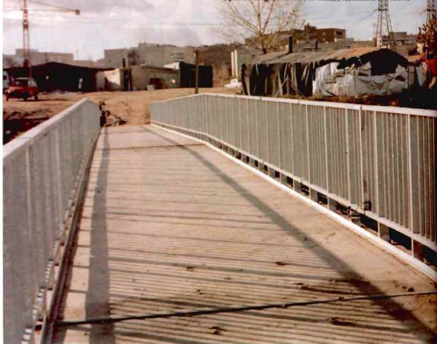
Pasarela sobre la Vía Borde de Hortaleza cercana al Barrio de Manoteras. La pasarela, que se construye para reposición de un antiguo camino, tiene la adecuación necesaria con el espacio al que se accede.
