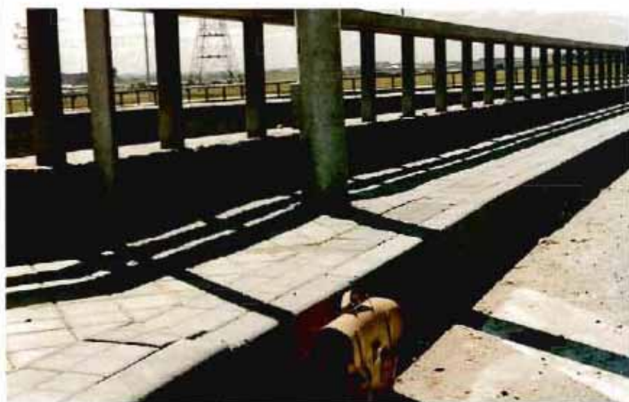
Como se aprecia las aceras son estrechas, y los bordillos muy altos.
