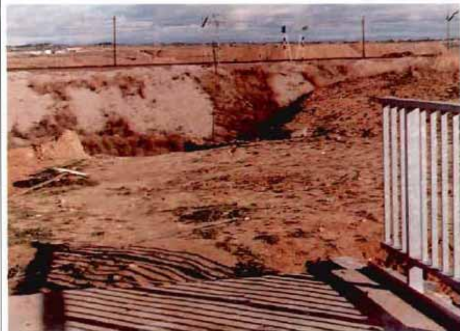
Pasarela sobre la Vía Borde de Hortaleza.
