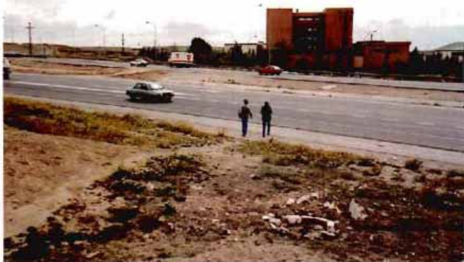
Cruce "salvaje" de la M-40 desde el Barrio de Palomeras Sureste en dirección al Complejo Educativo Arboleda. En este caso no existen vallas de protección de la autovía.
