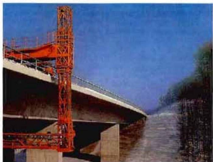
La gestión de puentes constituye una actual preocupación de la Dirección General de Carreteras del M.O.P.T.
