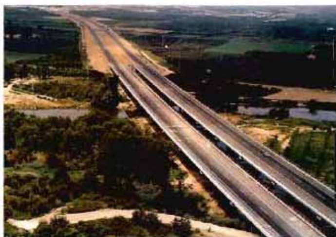
Dentro de la explotación de una red de carreteras presentan singular importancia los puentes que constituyen una parte muy importante del valor del patrimonio viario.
