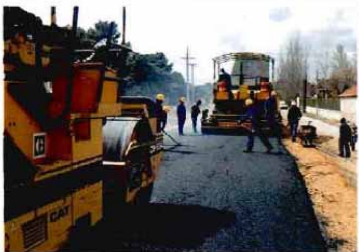
En España la gestión de carreteras, con especial atención a los firmes, se inició en las autopistas de peaje.
