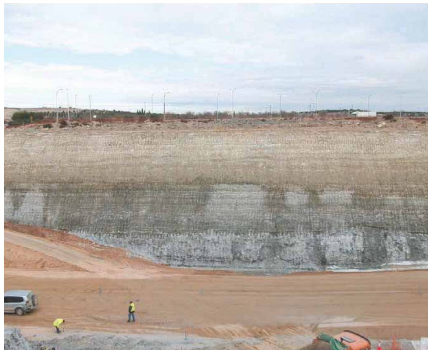
Construcción de una explanada o plataforma sobre materiales yesíferos con aportación de suelo.
