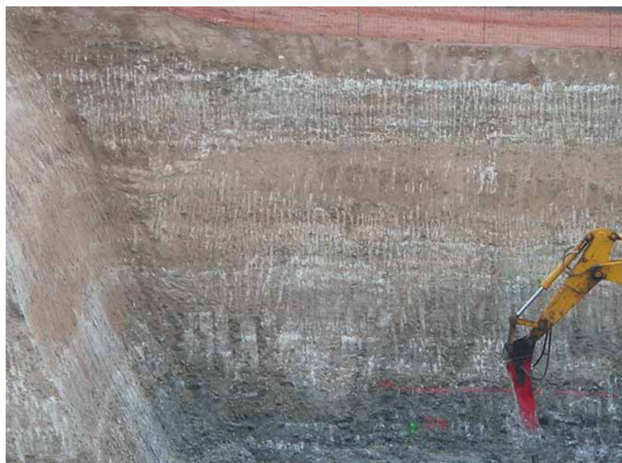
Talud y fondo de excavación en materiales yesíferos.
