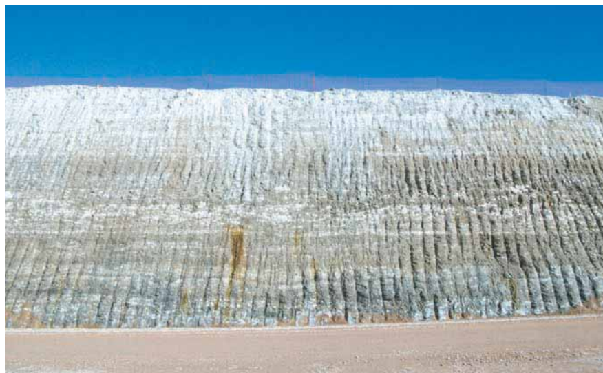
Aspecto de materiales con yesos. Se aprecia su color blanquecino.
