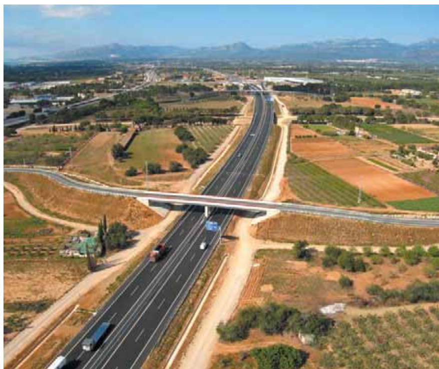
A lo largo del tramo se ha dispuesto 29 estructuras de distinto tipo.
