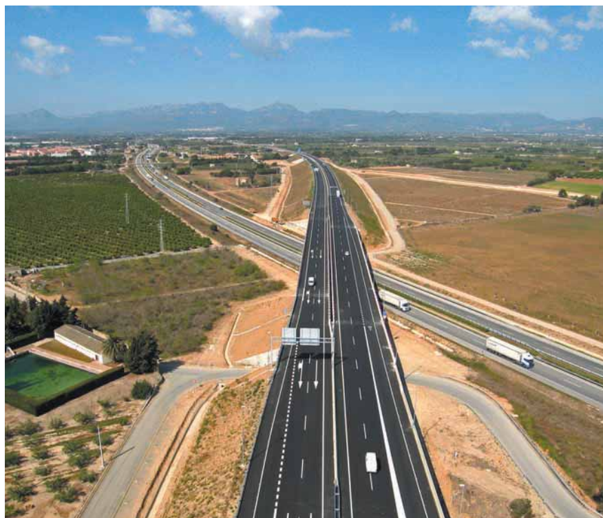
En la foto se aprecia como la nueva autovía cruza la AP-7.
