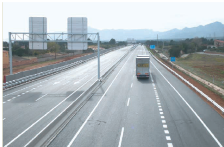
Vista del tramo desde el paso superior del enlace de Montbrío, dirección sur. P.k. 4+912.
