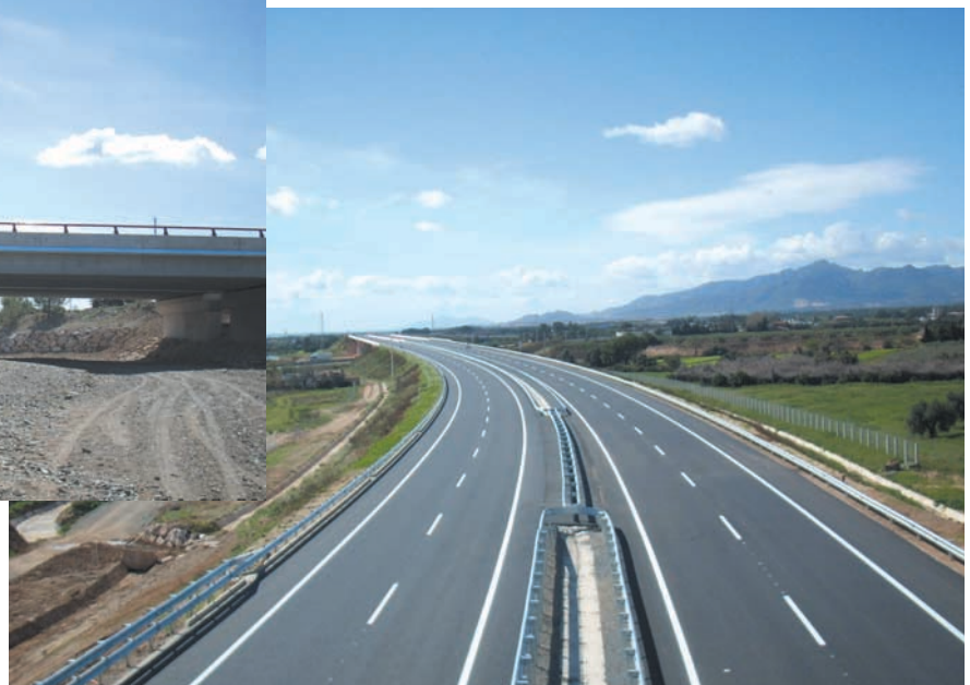
Foto izquierda: Viaducto sobre el barranco de Gené (p.k. 4+000). Foto derecha: Vista de la A-7 en dirección sur, desde el paso superior 3+443.
