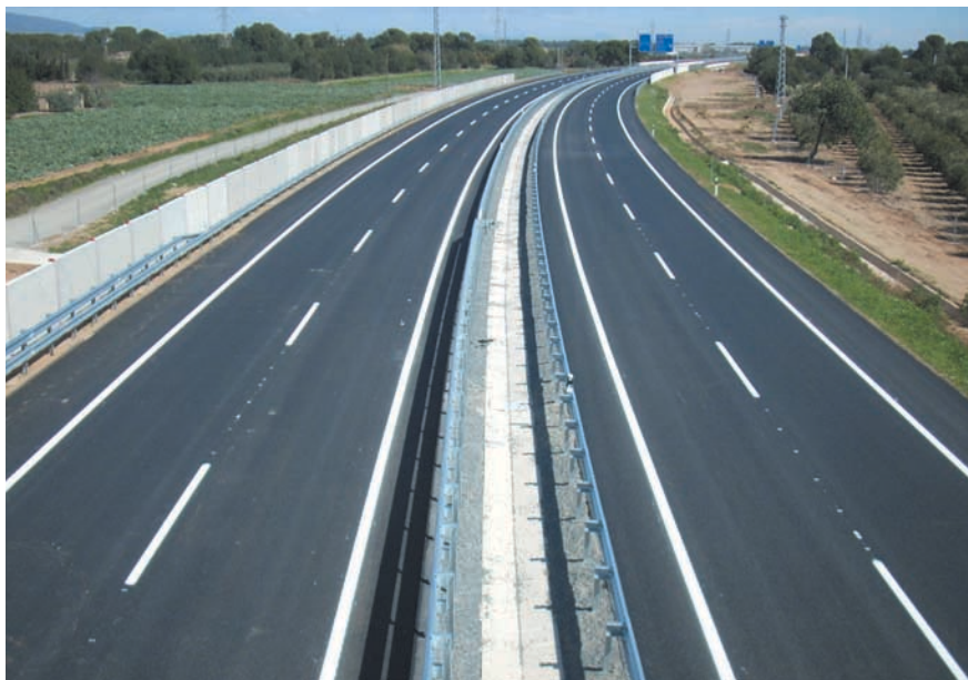
Vistas del tramo en sentido a Tarragona. P.k. 3+443.
