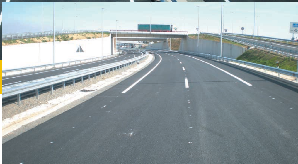
Foto derecha: Enlace de Mont-roig, p.k. 0+193 y Ramal 1 y 2.
