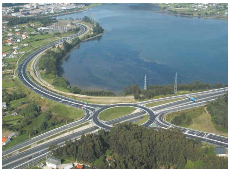
Enlace con la Autopista del Atlántico, en la intersección O Couto.
