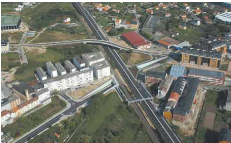
Vista del tramo Trinchera-Gándara donde pueden apreciarse el paso inferior O-6, el paso superior de tipología mixta y dos de las pasarelas del tramo.
