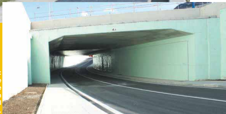
A la derecha: Reposición de la calle Obispo Argaya, donde se observa el cajón bajo la línea del ferrocarril.
