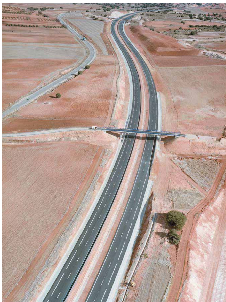
Se han construido un total de 5 pasos superiores con tableros postesados in situ, 3 puentes de vigas y 11 pasos inferiores.
