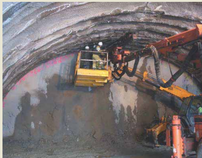
Ejecución de un paraguas de micropilotes en morrenas.
