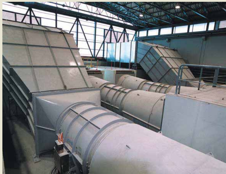
Interior del edificio de ventilación de la boca Sur.
