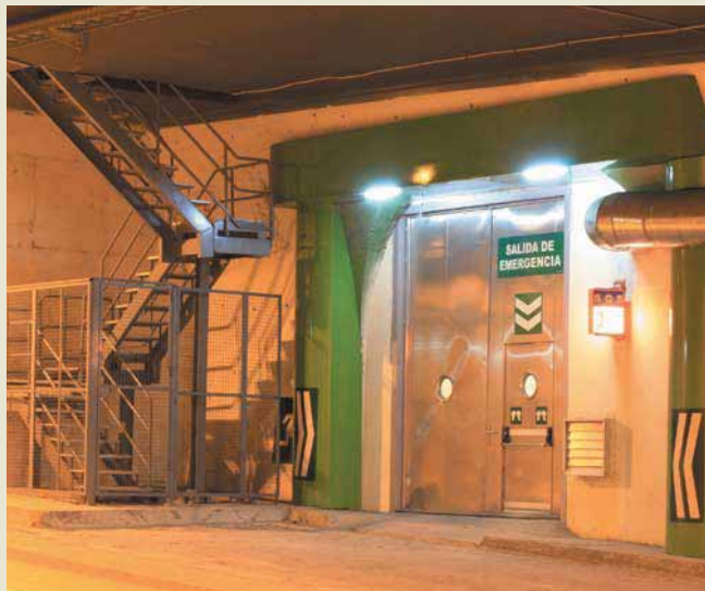
Arriba, la izquierda, interior del túnel, un carril de bajada y dos carriles de subida. A su derecha, entrada a refugio y escalera de acceso a cantones de ventilación. Foto inferior: Sala de control del túnel de Vielha.
