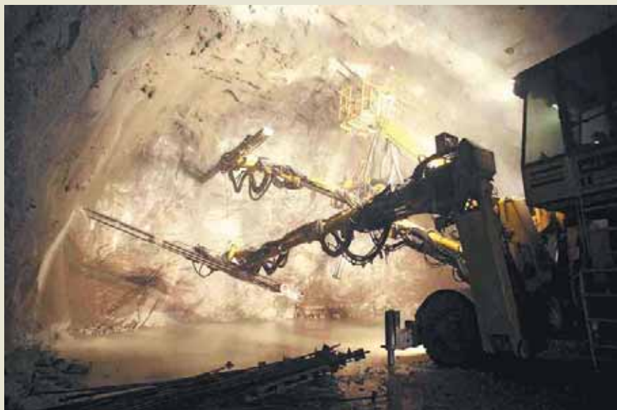
Perforación de un “pase” en granitoideas a sección completa.
