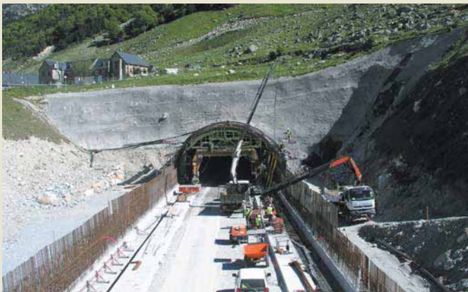
Inicio de la construcción de la bóveda del falso túnel en la boca Sur.
