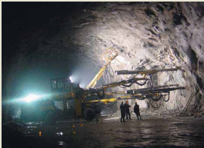
Inicio de la perforación de una galería de conexión.
