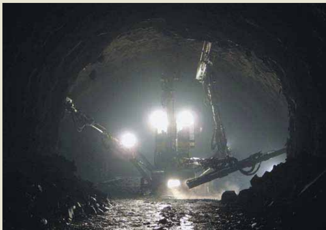
Perforación de ensanche en galería de ventilación existente
