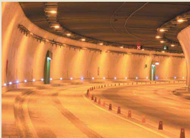
Vista interior del túnel en sentido Vielha-Lleida.
