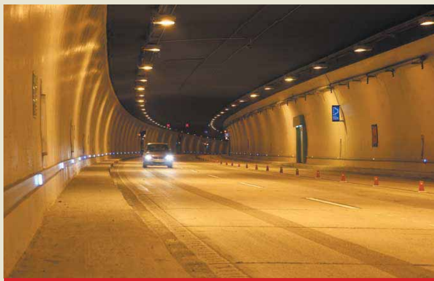
Vista interior del nuevo túnel de Vielha en servicio.
