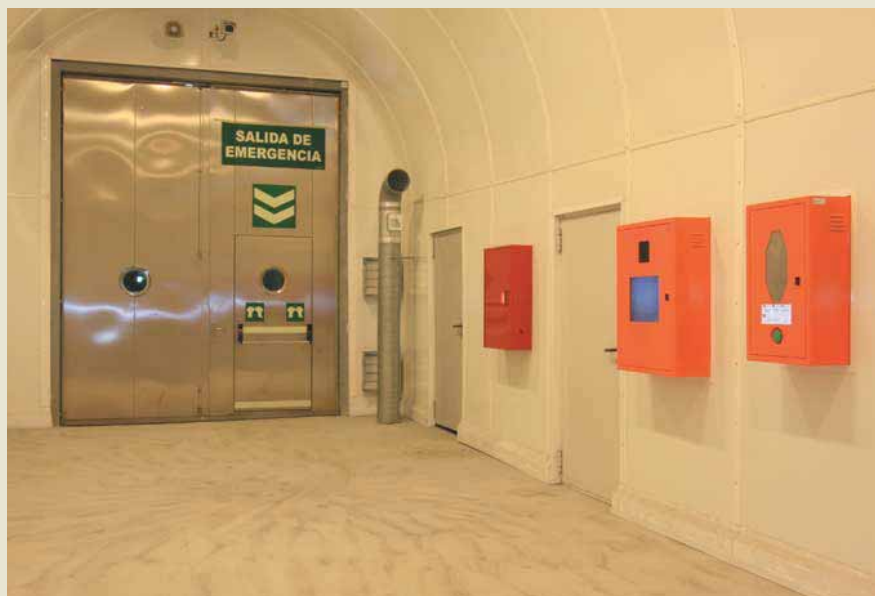
Vista interior de refugio.
