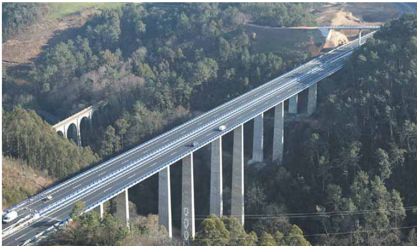
Viaducto de Cándano, de 6 vanos y 288 m de longitud, de tipo cajón mixto.
