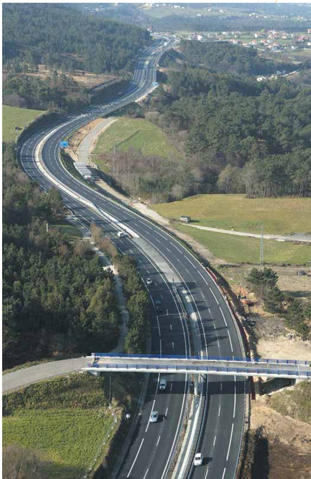
Vista general del tramo finalizado, con la población de Ballota al fondo.
