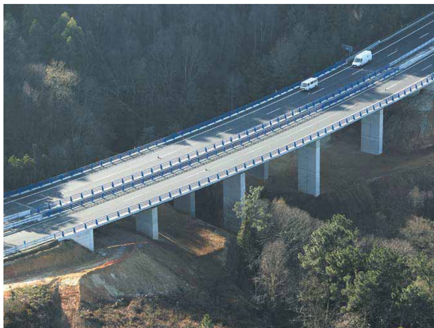
Viaducto de Las Arenas, de 104 m de longitud y 5 vanos.
