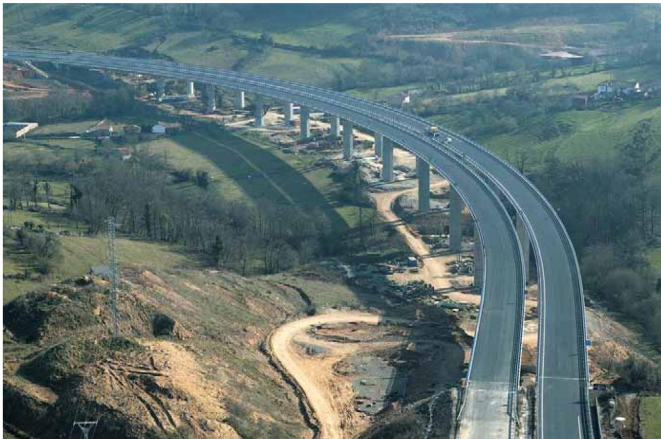
En la foto se aprecia el diseño en planta, prácticamente circular, del viaducto.
