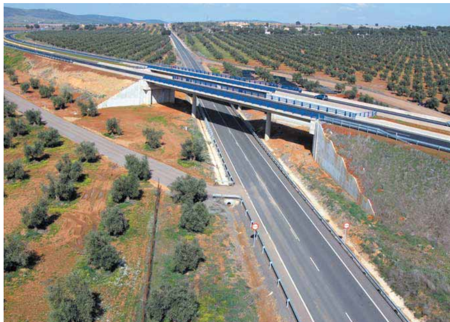
En la foto, paso superior sobre la N-420 (p.k. 302+002).
