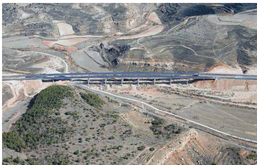
De arriba a abajo: Viaductos de Lechago y de Cuencabuena.
