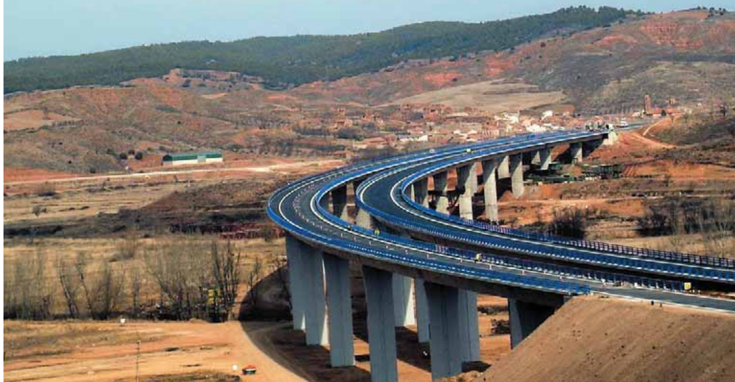
En la foto, viaducto de Lechago, de 916 m de longitud.
