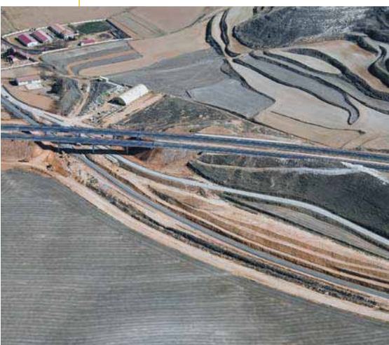
Foto superior: Viaducto de Valhondo. Foto inferior: Viaducto de Navarrete.
