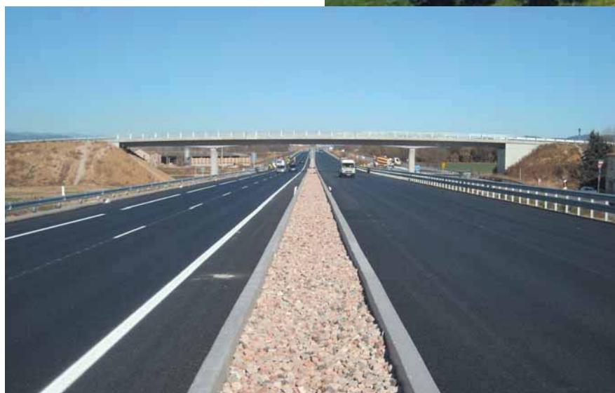
La mediana tiene 2 m de anchura (5 m entre bordes interiores de calzada).
