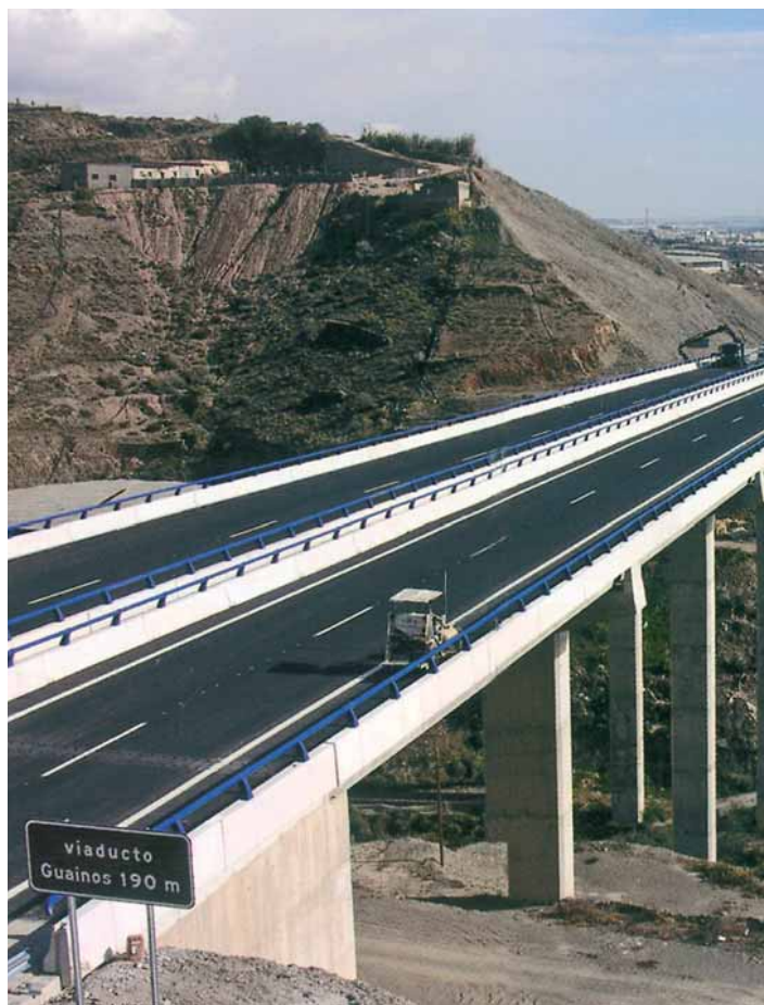
Viaducto de Guainos Bajos, de 189,9 m de longitud, formado por dos tableros independientes.
