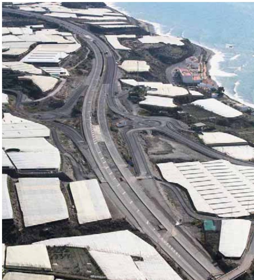
Enlace de Adra, de tipo diamante con glorietas.
