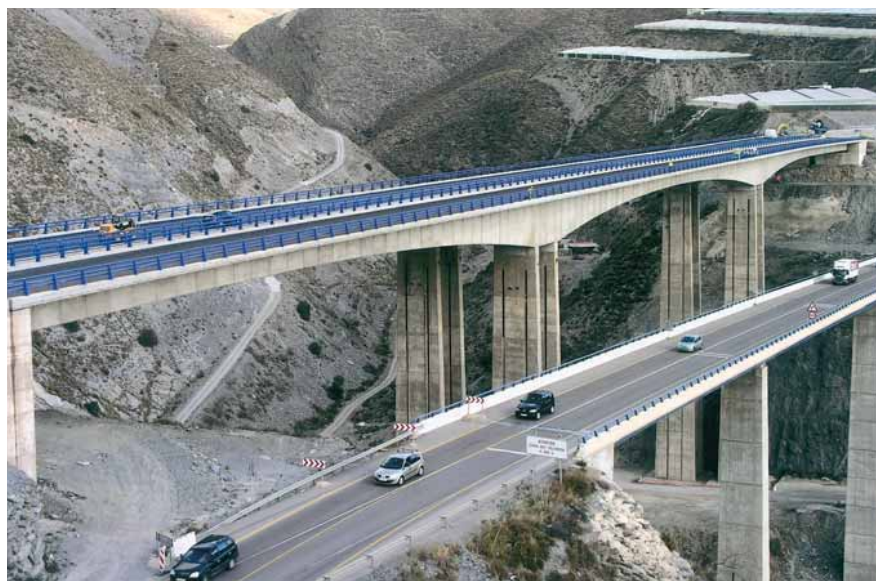
Viaducto de Huarea, de 301,52 m de longitud, y 85 m de altura sobre el fondo de la rambla.
