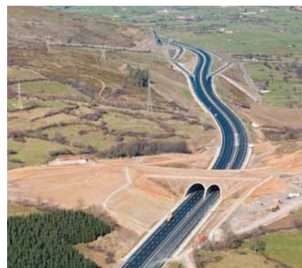
Túnel de Somaconcha.
