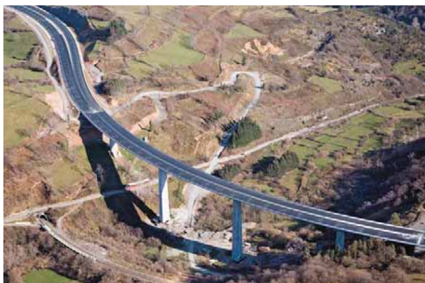
Viaducto de Pujayo.
