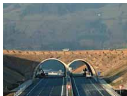
Falso túnel de Molledo.
