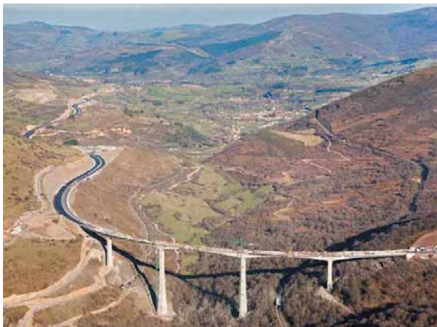
Viaducto de Montabliz.
