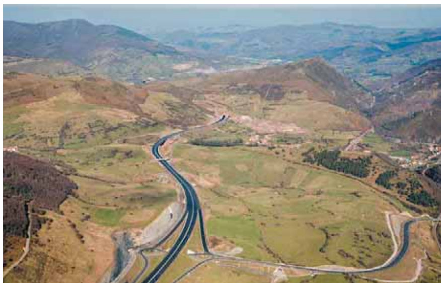
Vista general del tramo finalizado, de 11,87 km de longitud.
