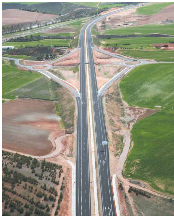
Enlace de Huelves, que permite la conexión con la CUV-2002 y la población de Huelves.
