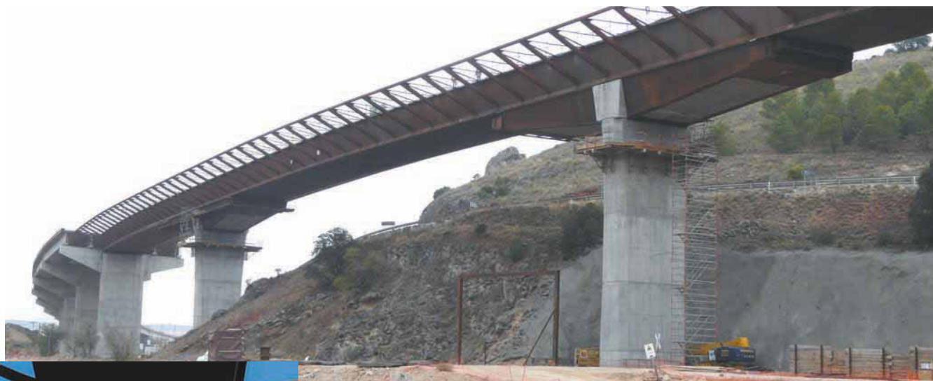
Ambas fotos pertenecen al viaducto 2 del Estrecho de Paredes. En ellas, se aprecian el detalle de unión en pila mixta con el viaducto 3, así como una imagen en perspectiva desde la base de las pilas.
