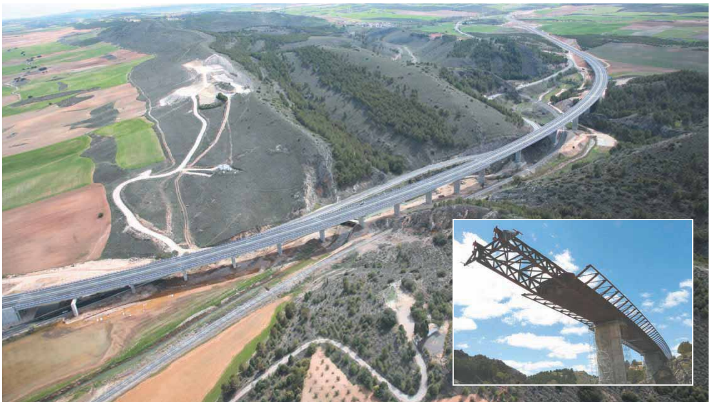
La foto de fondo corresponde a una vista aérea del viaducto de Paredes. Abajo, a la derecha, foto realizada durante el lanzamiento del viaducto 2 del Estrecho de Paredes. Viaducto mixto sobre ábacos metálicos. Vista de nariz de lanzamiento.
