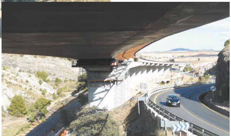
Foto superior: Vista de ábacos metálicos durante el lanzamiento del viaducto 2 del Estrecho de Paredes. Foto inferior: detalle de unión en pila mixta con el viaducto 3 (vigas doble T).
