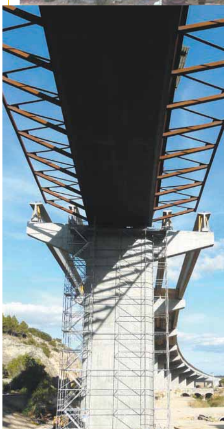
Ambas fotos pertenecen al viaducto 2 del Estrecho de Paredes. En ellas, se aprecian el detalle de unión en pila mixta con el viaducto 3, así como una imagen en perspectiva desde la base de las pilas.
