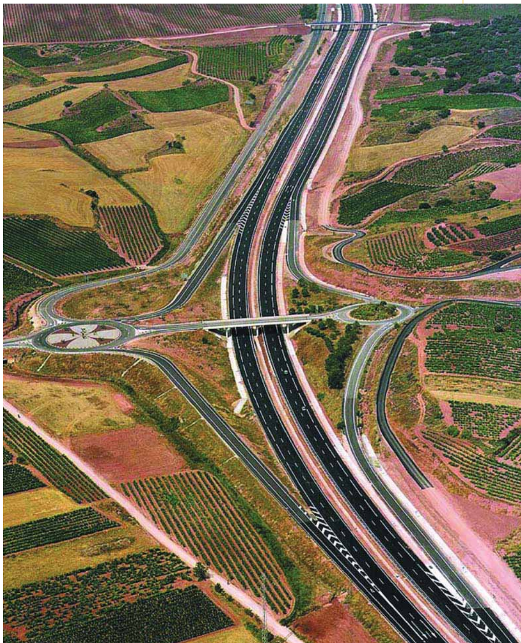
Vista parcial del tramo que ha supuesto una inversión aproximada de 33 millones de euros.
