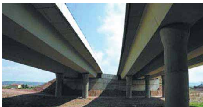
Viaducto sobre el río Yalde.
