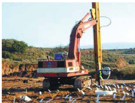
Ejecución de mechas drenantes (foto izquierda) y obra de fábrica 4.4 (derecha).
