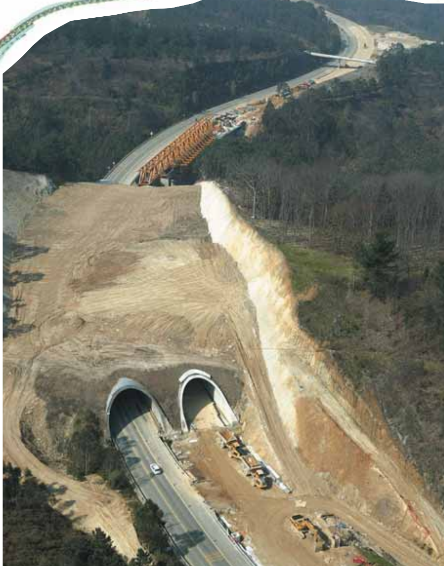
Construcción de nueva galería en el falso túnel, paralela al existente.
