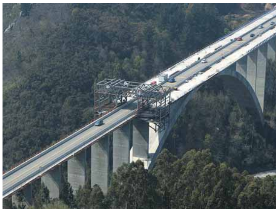
Vista aérea del tablero durante la ampliación. Colocación de voladizos metálicos y viga de borde, y hormigonado de la losa mediante carro portaencofrados.
