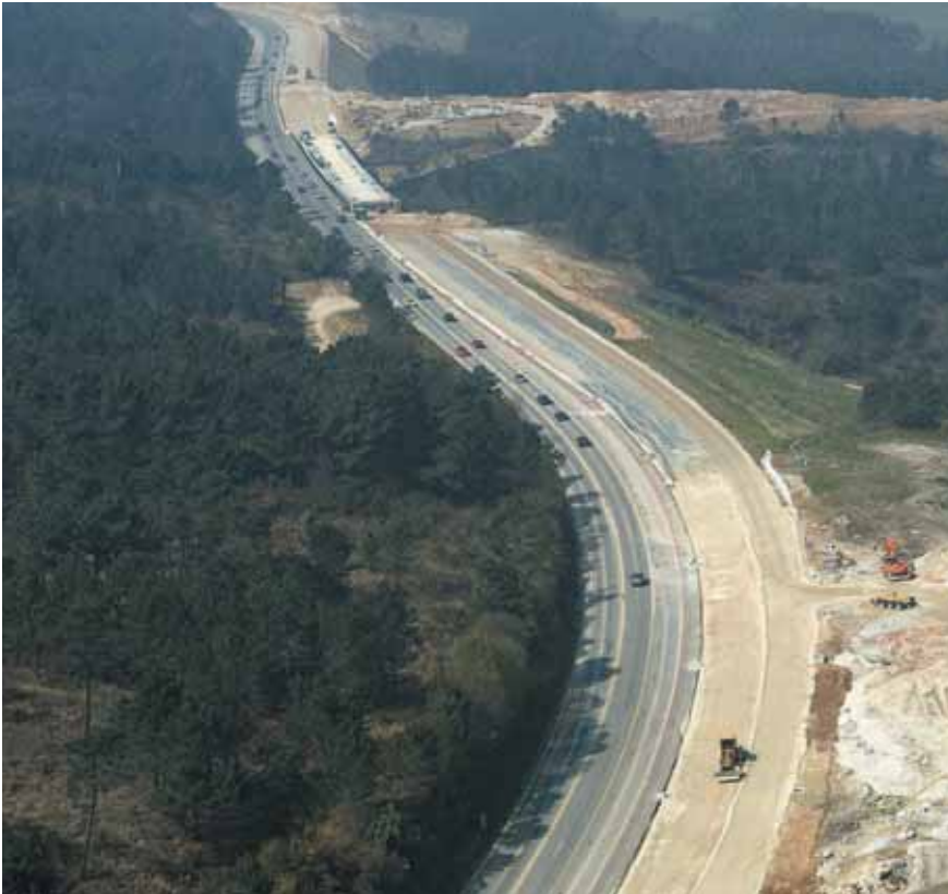
Viaducto de Ferreras en fase de construcción, constituido por un tablero continuo de 11,50 m de anchura y 139,50 m de longitud total distribuidos en 5 vanos.
