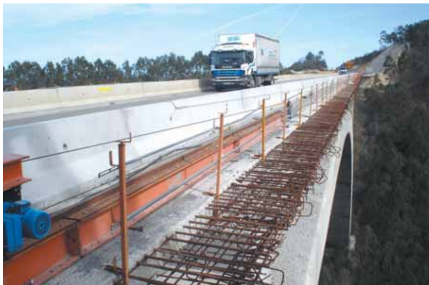
Hidrodemolición del voladizo de hormigón existente.
