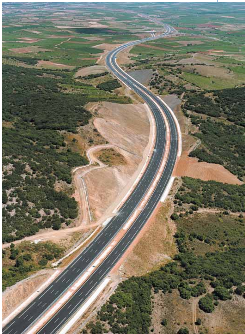
Vista general del tramo Mainar-Paniza, de 13 km de longitud, y que ha supuesto una inversión de 60,941 millones de euros.
