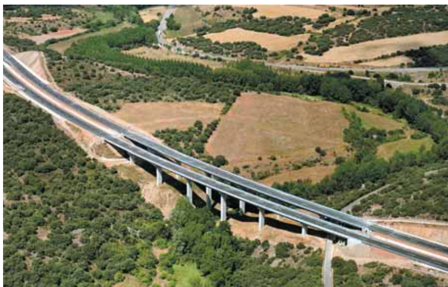
Viaducto del río Huerva.
