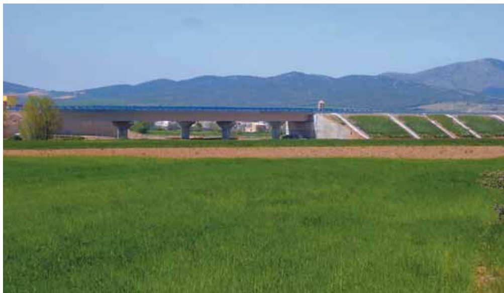
Viaducto de río Huerva.
