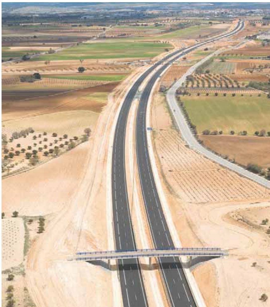
Se han dispuesto 9 pasos superiores, 3 inferiores, ampliado dos tableros de dos pasos superiores existentes en la A-3 y actuado en otras dos estructuras en la misma autovía.
