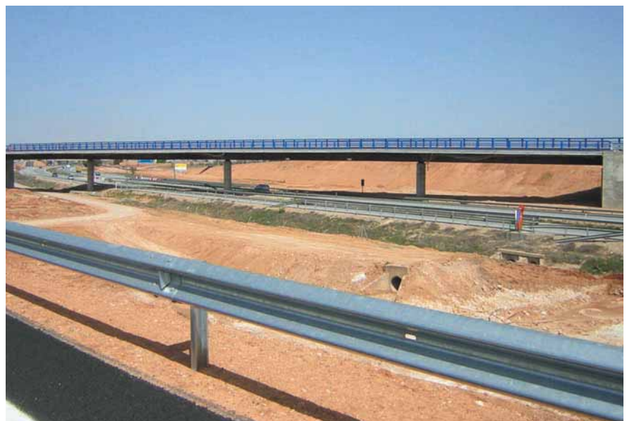
Vista general de la estructura finalizada.
