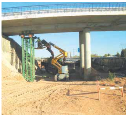
2. Apeo y gateo del tablero existente.
