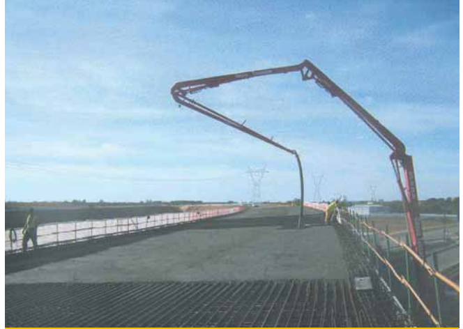
Homigonado, del tablero una vez colocadas las prelasas y la ferralla.
