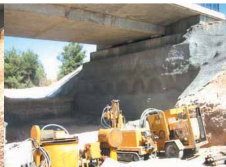
1. Ejecución de muros de soil nailing bajo estribos existentes.
