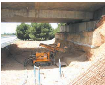
1. Ejecución de muros de soil nailing bajo estribos existentes.
