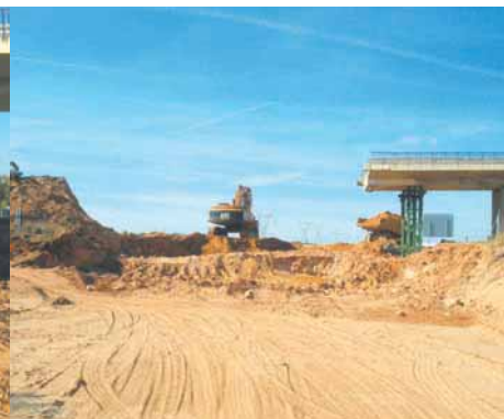
3. Demolición de los estribos existentes.
