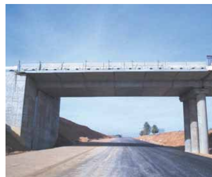
6. Tablero de uno de los vanos finalizado.
