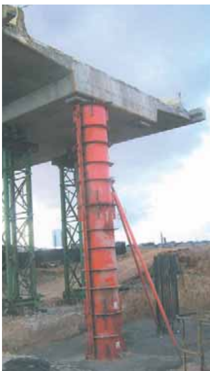
4. Ejecución de las pilas.
