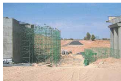
5. Cimbrado de los tableros ampliados.
