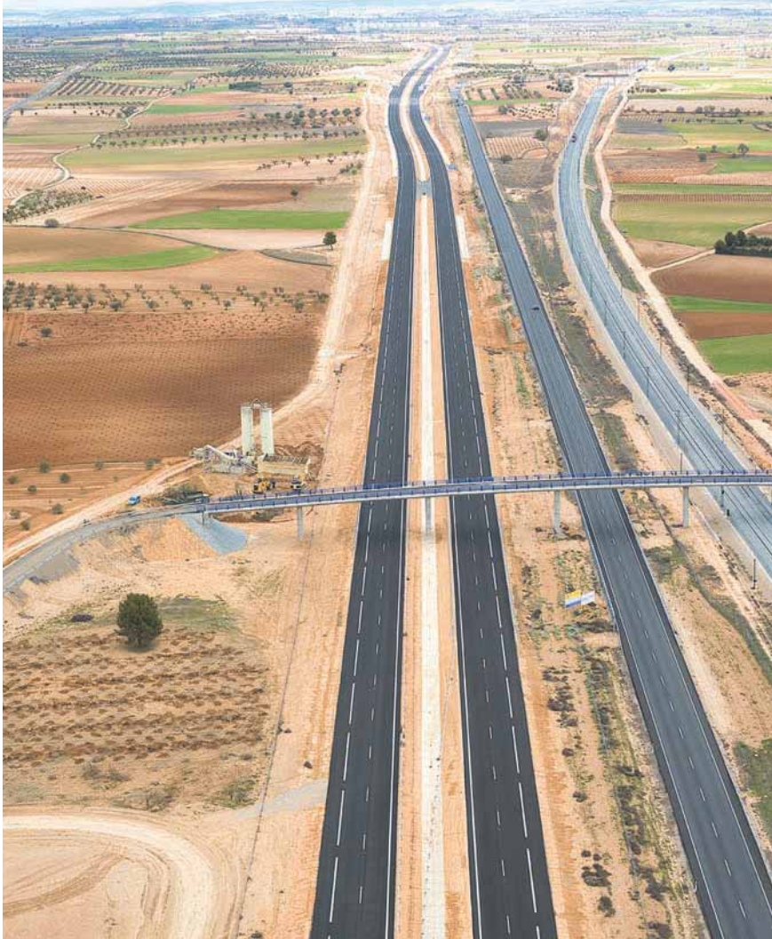
Vista general de la autovía en su inicio.
