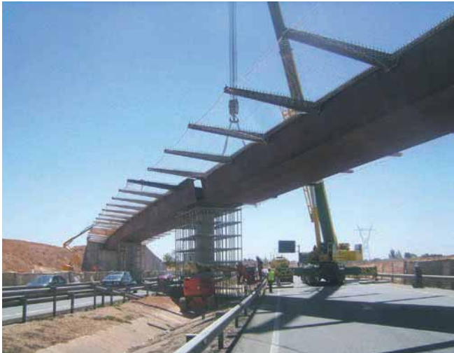
Montaje del cajón metálico.
