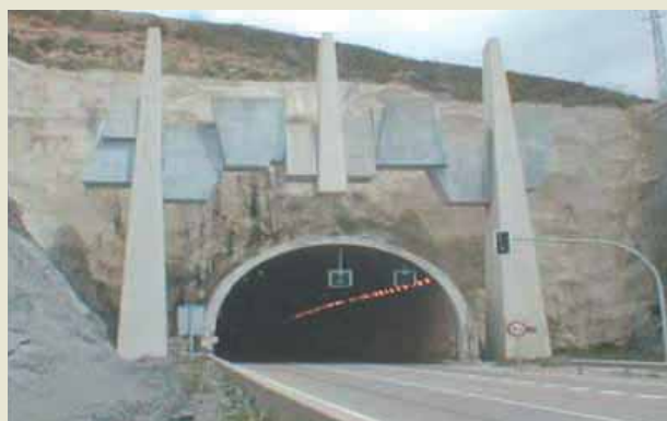
Figura 11. Vista de la boquilla de entrada.
