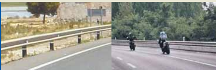
Figura 5- Protección de caucho reciclado N-344. Nueva valla de protección.
